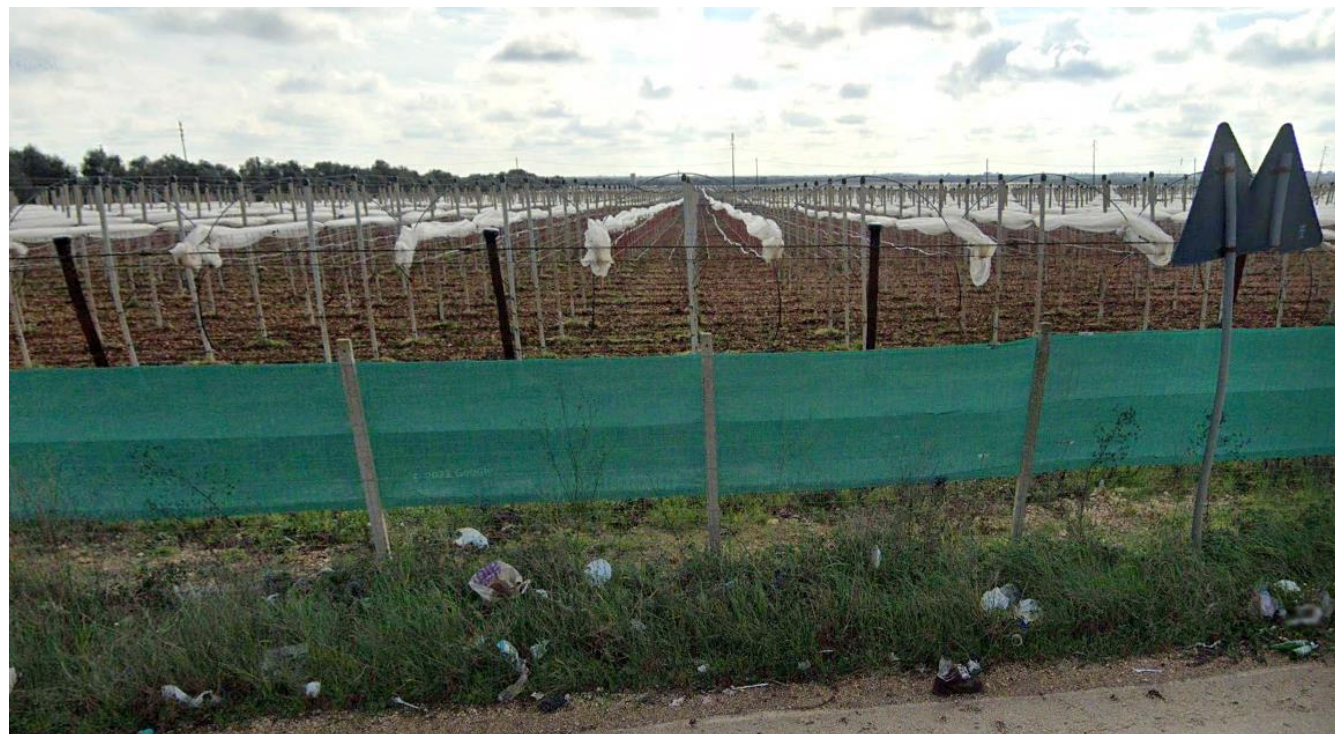
Area Stazione Terna
