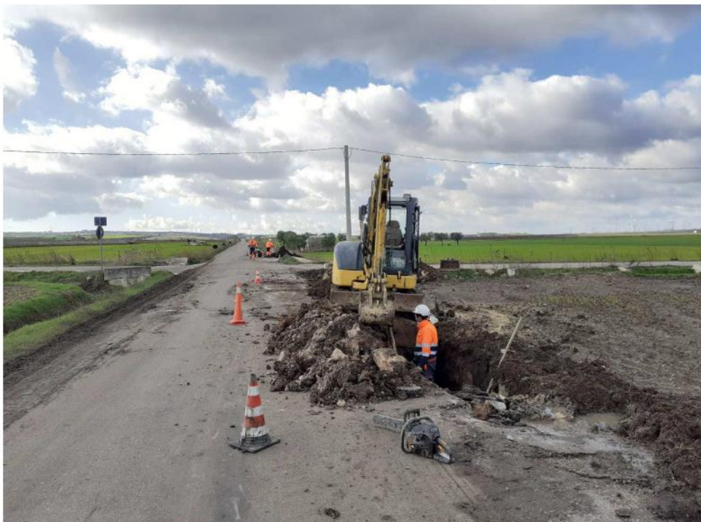
Esecuzione di Trivellazione orizzontale controllata
