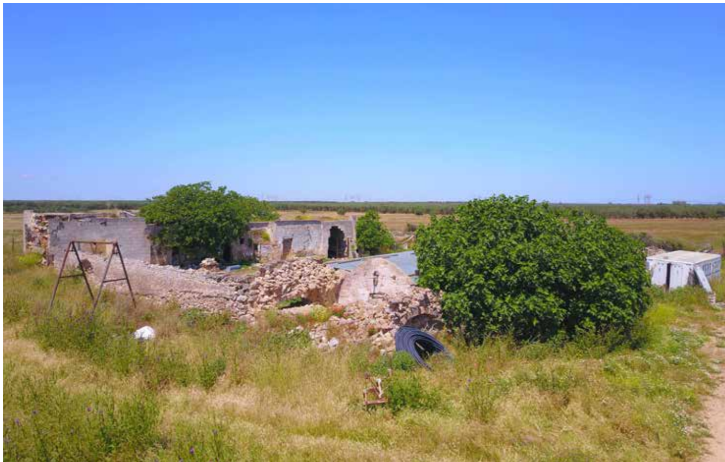
Foto Masseria Rocco Nuzzo stato di fatto
