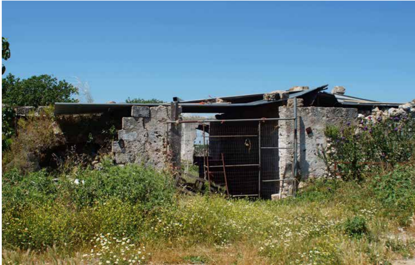
Foto Masseria Rocco Nuzzo stato di fatto
