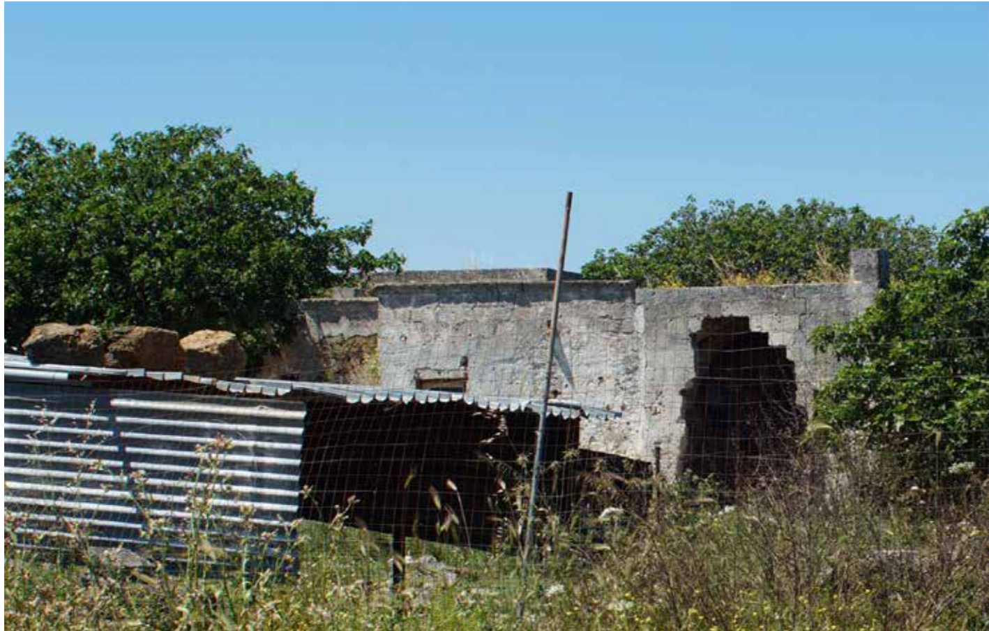
Foto Masseria Rocco Nuzzo stato di fatto
