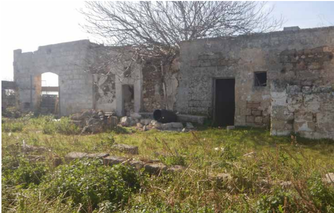
Foto Masseria Rocco Nuzzo stato di fatto
