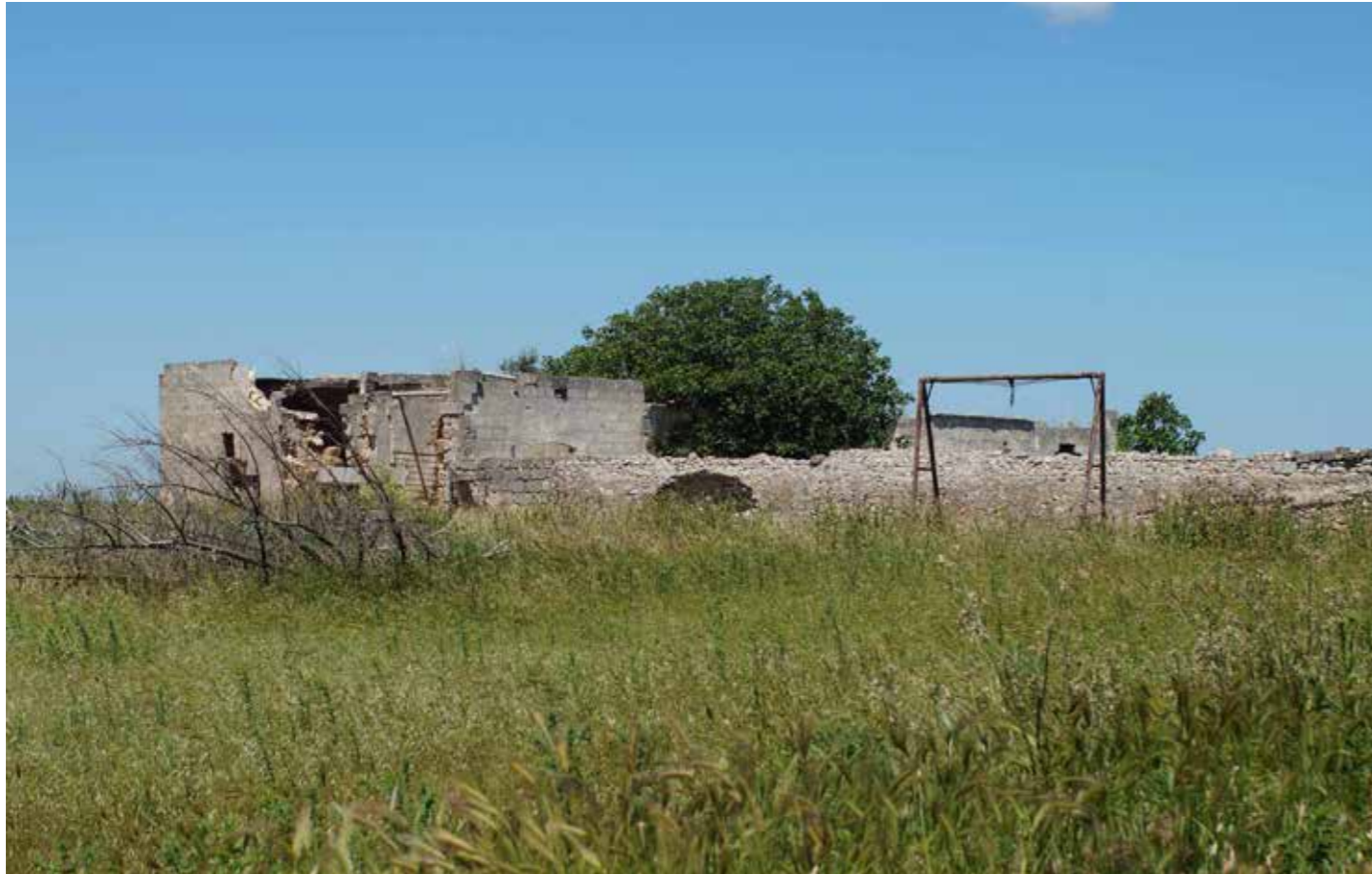
Foto Masseria Rocco Nuzzo stato di fatto
