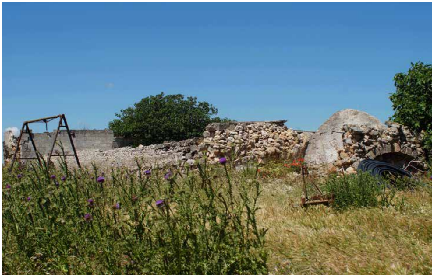
Foto Masseria Rocco Nuzzo stato di fatto
