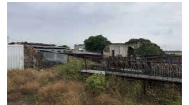
Foto masseria Roco Nuzzo, stato di fatto
