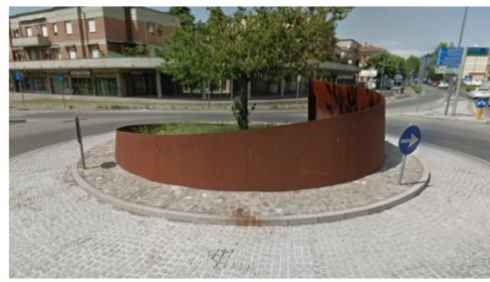
[7] Riferimento progettuale installazione ingresso: pannelli in acciaio corten con elementi intagliati a laser.
