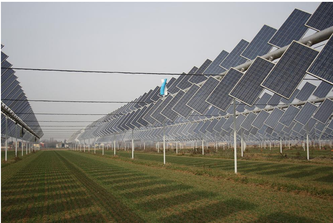
Figura 7. Sistema agrovoltaico ad inseguimento, dotato di doppio asse di rotazione, realizzato dalla “Rem Tec” ed installato in Italia, Monticelli D’Ongina (PC). Riferimenti: Praderio e Perego (2017), Rem Tec (2017).
