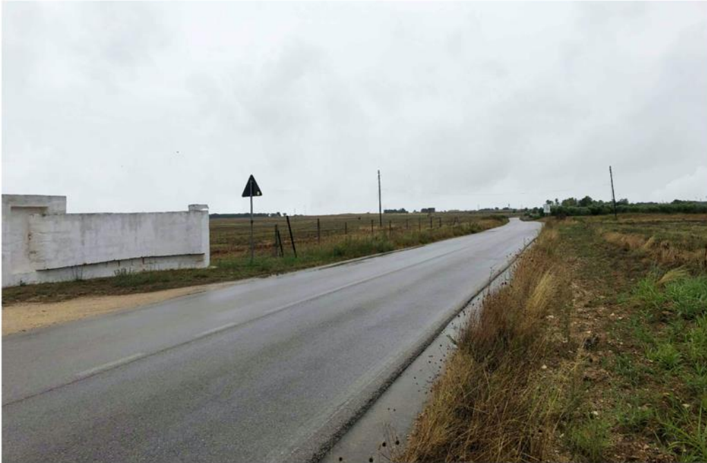
Sito: Grotte. Stato di Fatto
