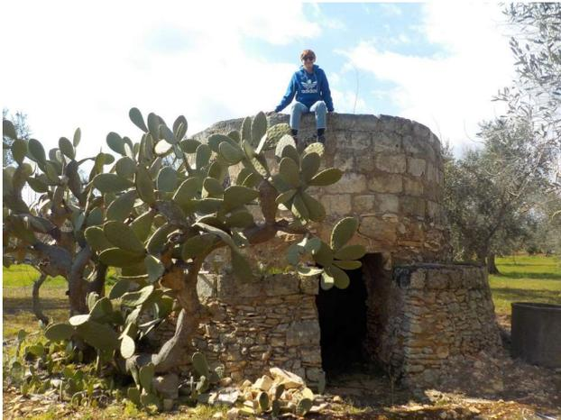
Figura 48. Pajara atipica. La parte superiore è costruita in muratura e non a secco. Probabilmente è nata come lamia coperta da materiale vegetale con muri in pietra a secco ed in seguito modificata.
