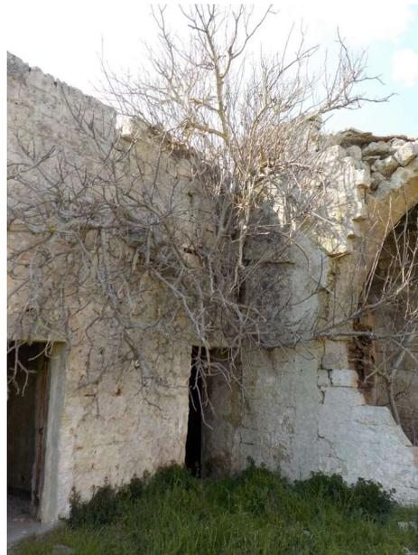
Figura 75. Interno della Masseria Montefusco. È evidente lo stato di abbandono e degrado: il fico che cresce nella parete ha contribuito al crollo di diversi elementi architettonici.
