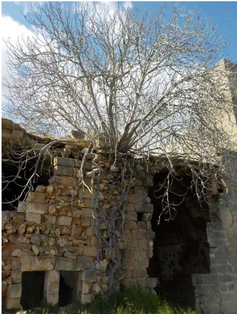
*Figura 69. Masseria Corte Finocchio in stato di abbandono e crollo. Il fico ha contribuito a destabilizzare le murature portanti.*
