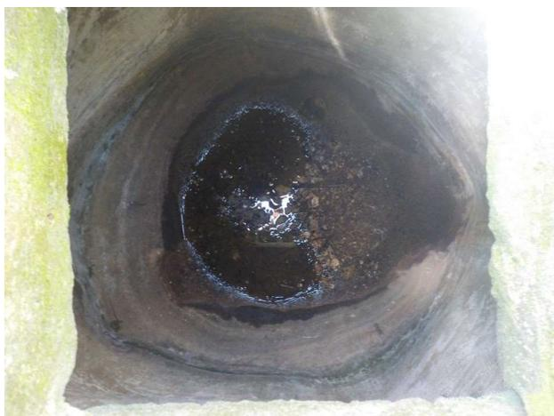
Figura 82. Interno intonacato di una piccola vecchia cisterna completamente scavata nel terreno.
