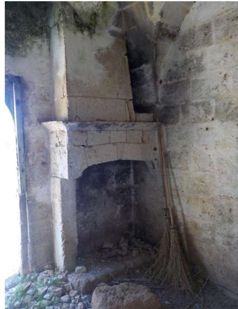
Figura 55. Focolare della seconda lamia. Verso l'alto sono visibili le appese della volta a squadro.
