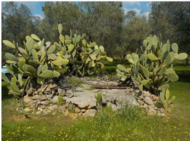
Figura 79. Bocca di una vecchia cisterna con vera a fior di terra e piano di raccolta dell'acqua piovana, circondata da vegetazione ripariale (fico d'India).
