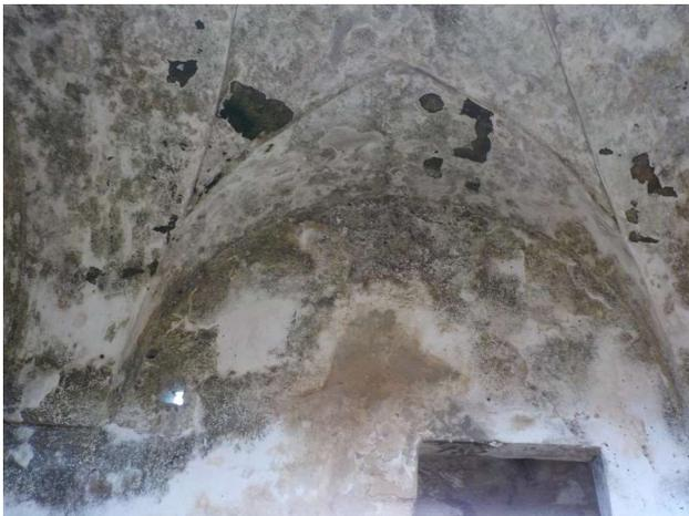
Figura 50. Volta a spigolo della prima lamia.
