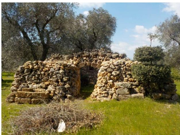
Figura 46. Lamia con pareti a secco, mancante del tetto, vista frontalmente. Probabilmente il tetto era costituito da travi in legno e cannucciato con calce e copertura in coppi.
