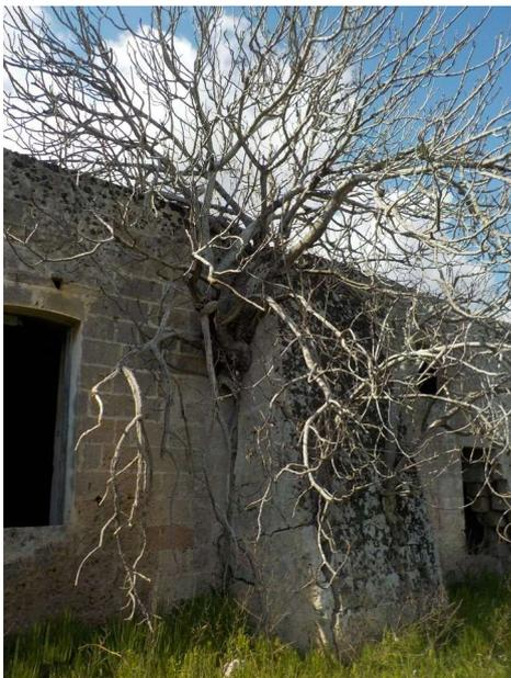
*Figura 72. Masseria Corte Finocchio in stato di abbandono e crollo. Il fico ha contribuito a destabilizzare le murature portanti.*
