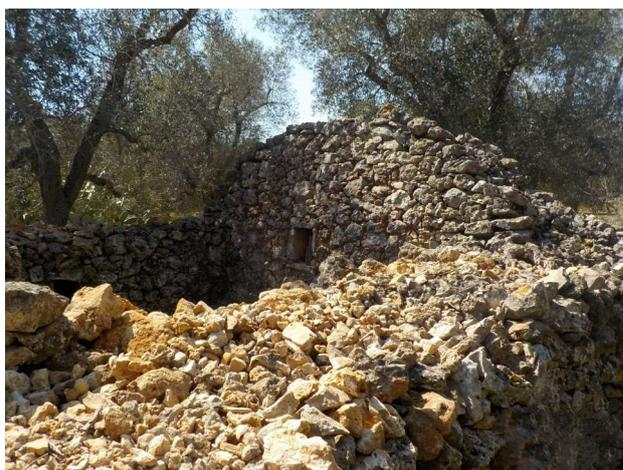
Figura 47. Lamia con pareti a secco, mancante del tetto. Probabilmente il tetto era costituito da travi in legno e cannucciato con calce e copertura in coppi. È visibile la forma curva della sommità del muro anteriore e posteriore che lascia intendere la presenza di un vecchio tetto spiovente.
