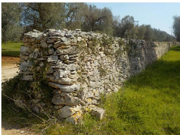
Figura 78. Interruzione di muro a secco in buono stato di manutenzione.
