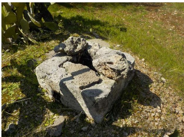
Figura 81. Bocca di una vecchia cisterna con vera a fior di terra.
