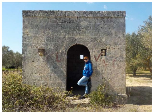
Figura 53. Seconda lamia vista di fronte. Sono visibili i due fori nella parete utilizzati per incastrare i pali della tettoia in canne.
