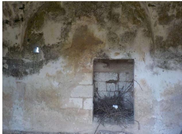
Figura 51. Focolare e appese della volta a spigolo della prima lamia.
