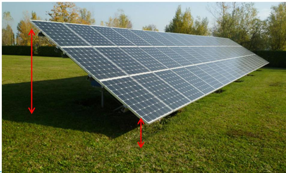
Fig. 4.4 Disposizione pannelli con indicazione della distanza dal terreno di posa
