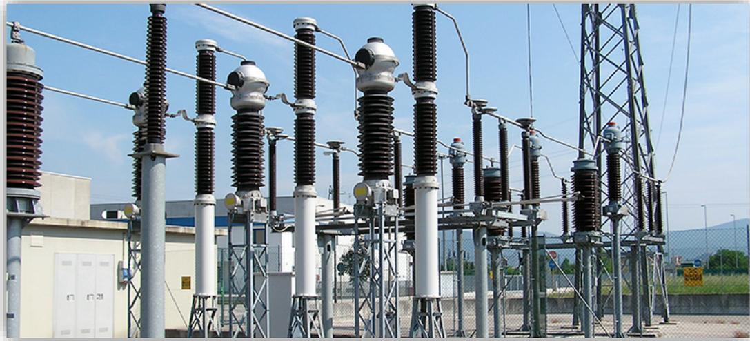
**Figura 10 – Esempio stalli stazione MT/AT**
