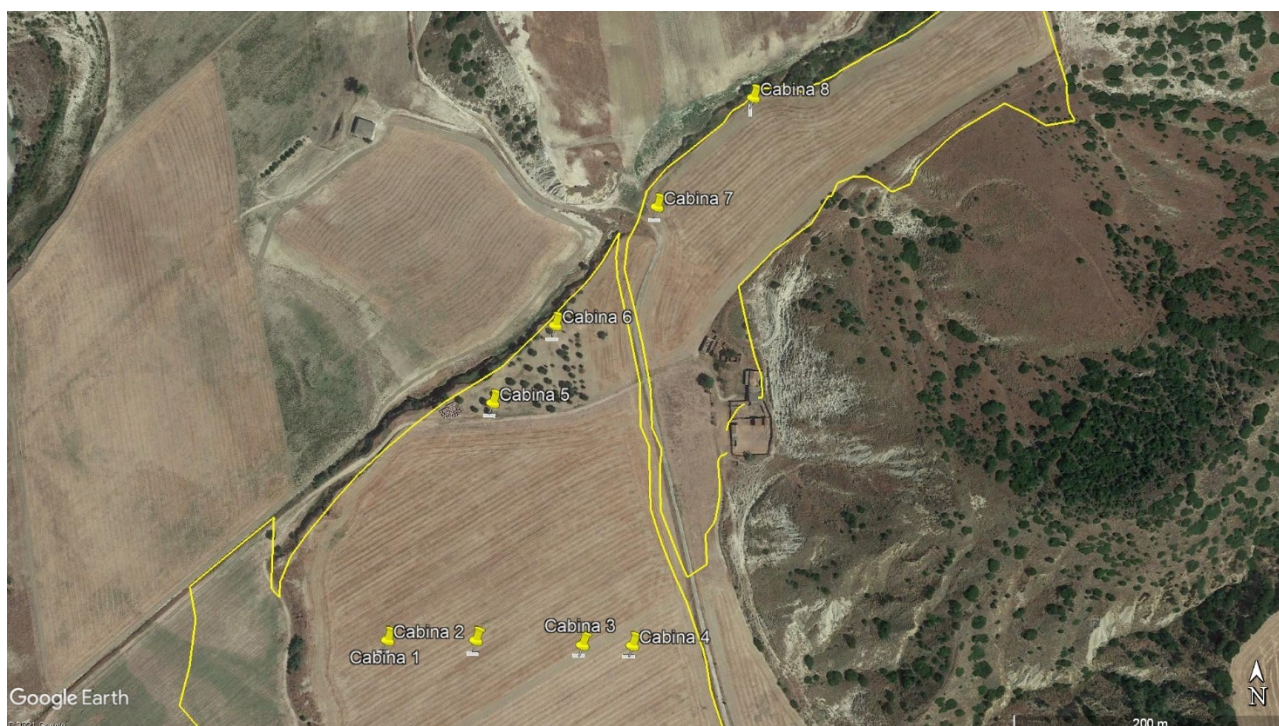
Figura 6 – Campi e cabine
