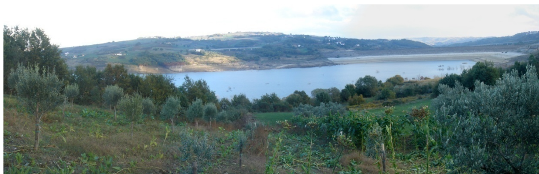
Figura 4.g: Diga di Campolattaro
