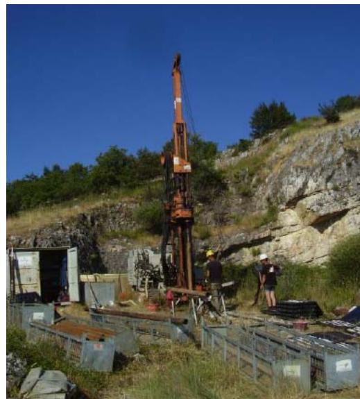
Figura 4.d: Cantiere di Perforazione – Sonda Puntel PX 800
