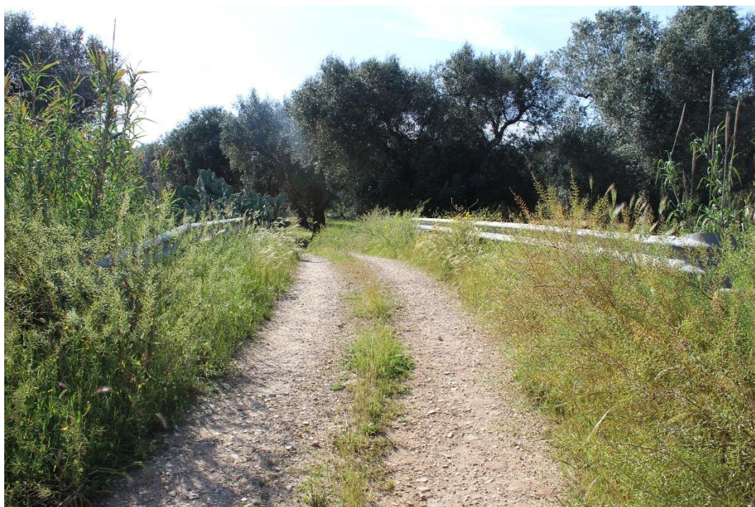
Figura 4 - Attraversamento Strada Vicinale zona Canale Reale
