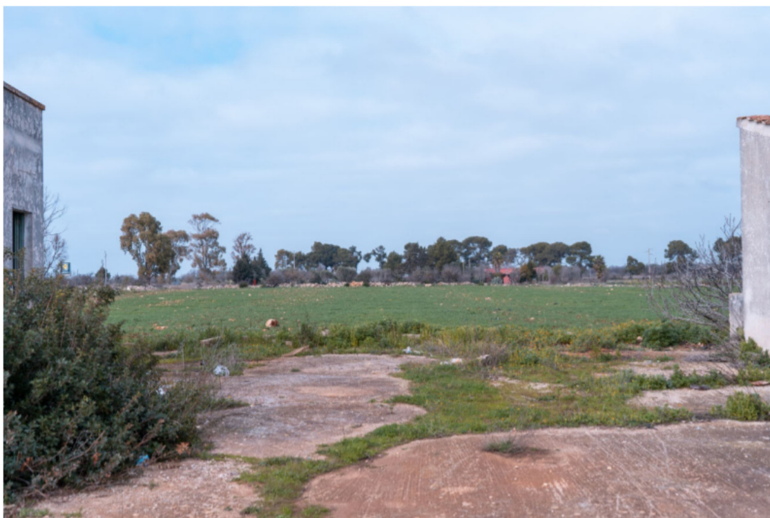
Figura 37: Vista del complesso di fabbricati della riforma verso lato Nord dell'impianto, con mitigazione visiva dovuta a filari di alberi, compresi ulivi affetti da Xylella
