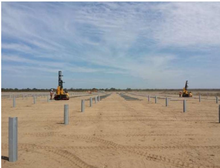
*Figura 8. Esempio di disposizione dei pali di fondazione delle strutture*
