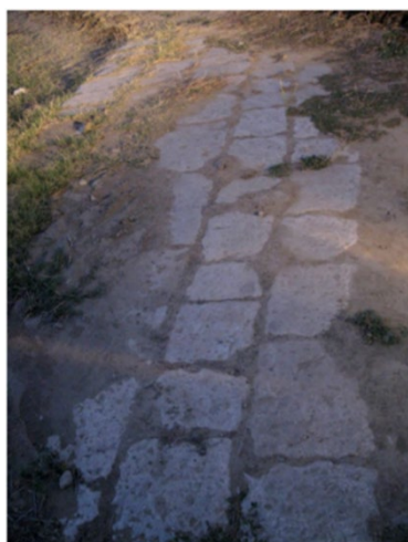
Figura 9- Basolato di pavimentazione della via Herdonitana
