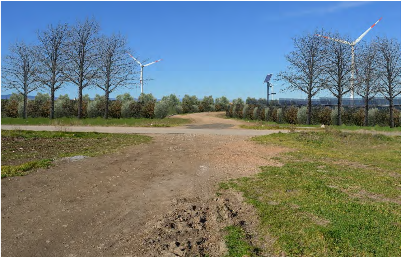
FS. 1 POST OPERAM- La foto mostra l'impianto agro-voltaico in esercizio, con le fasce di mitigazione suggerite dalla vegetazione spontanea di margine
