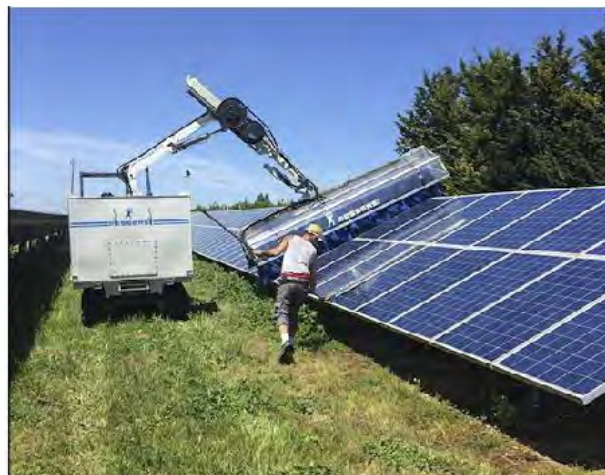
Figura 27 - Pulizia meccanizzata dei pannelli
