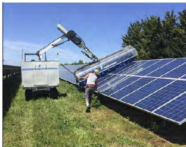
Figura 44-Pulizia meccanizzata dei pannelli
