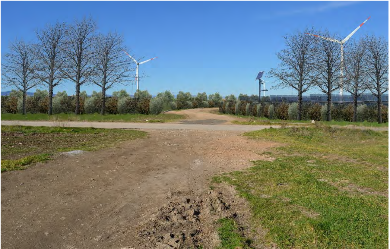
FS. 1 POST OPERAM- La foto mostra l'impianto agro-voltaico in esercizio, con le fasce di mitigazione suggerite dalla vegetazione spontanea di margine
