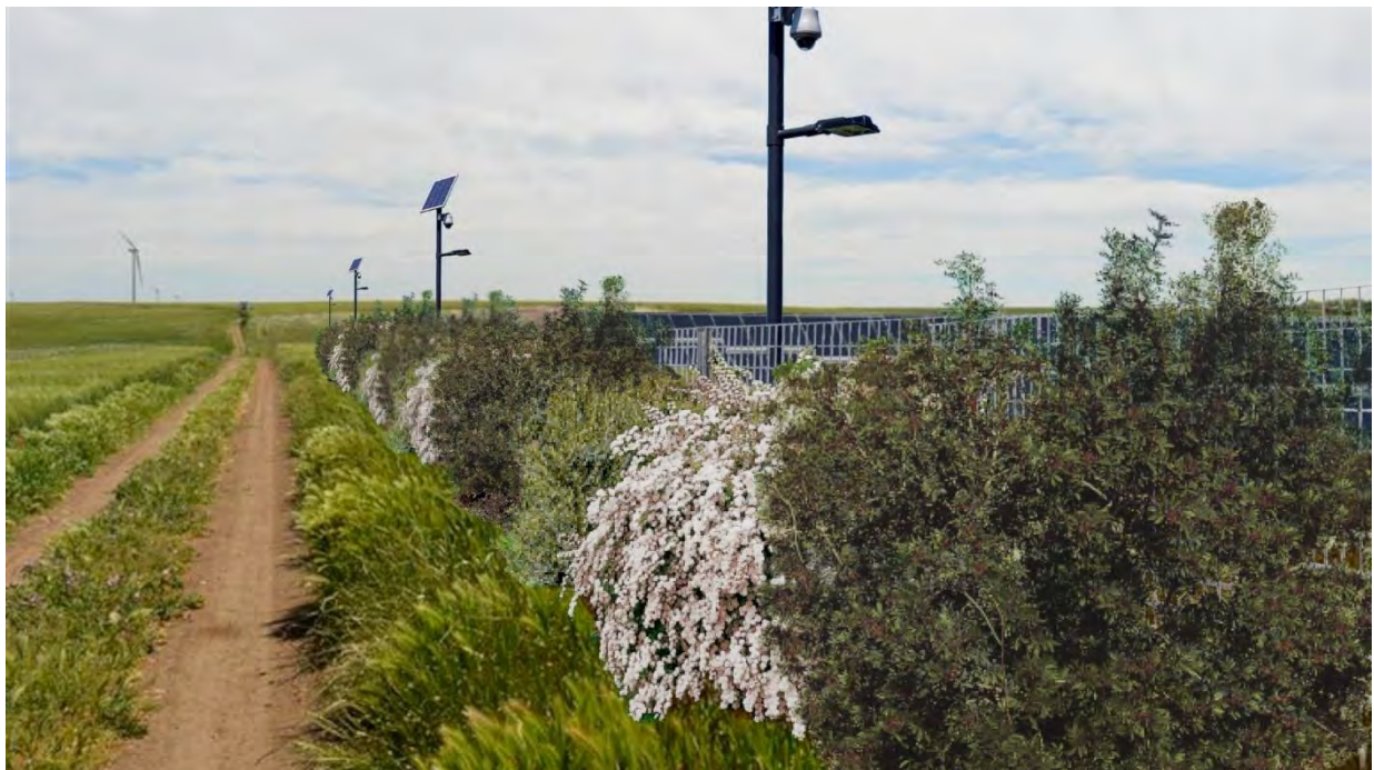
FS. 2 POST OPERAM - Dalla foto, che simula l'impianto agro-voltaico in esercizio, è possibile vedere l'uso del suolo agricolo a seminativo di progetto e le fasce di mitigazione suggerite dalla vegetazione spontanea di margine
