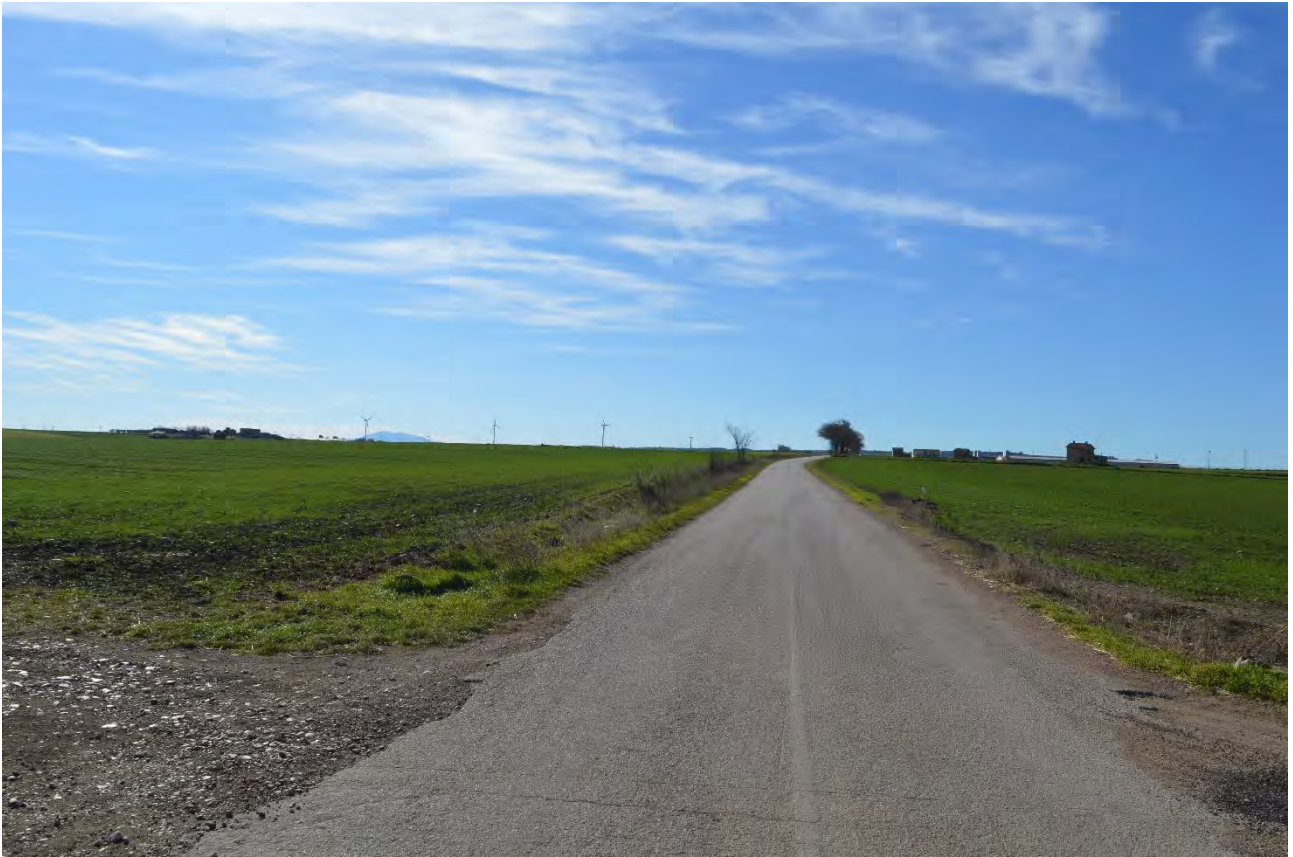
FS. 3 ANTE OPERAM- Foto scattata all'interno del lotto A, in direzione sud
