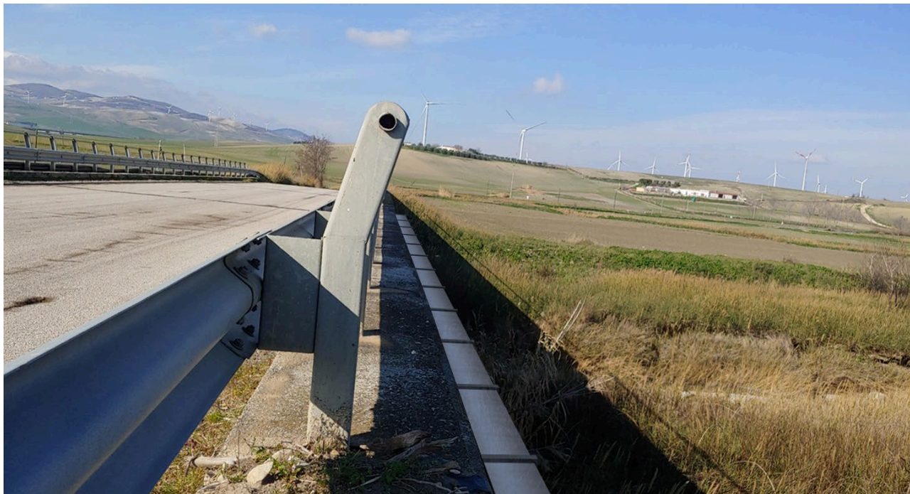
Figura 33 – Attraversamento Torrente Carapelle - POST OPERAM
