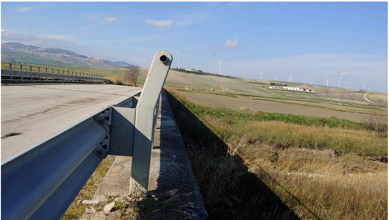
Figura 32_ INTERFERENZA 02 Attraversamento Torrente Carapelle –ANTE OPERAM
