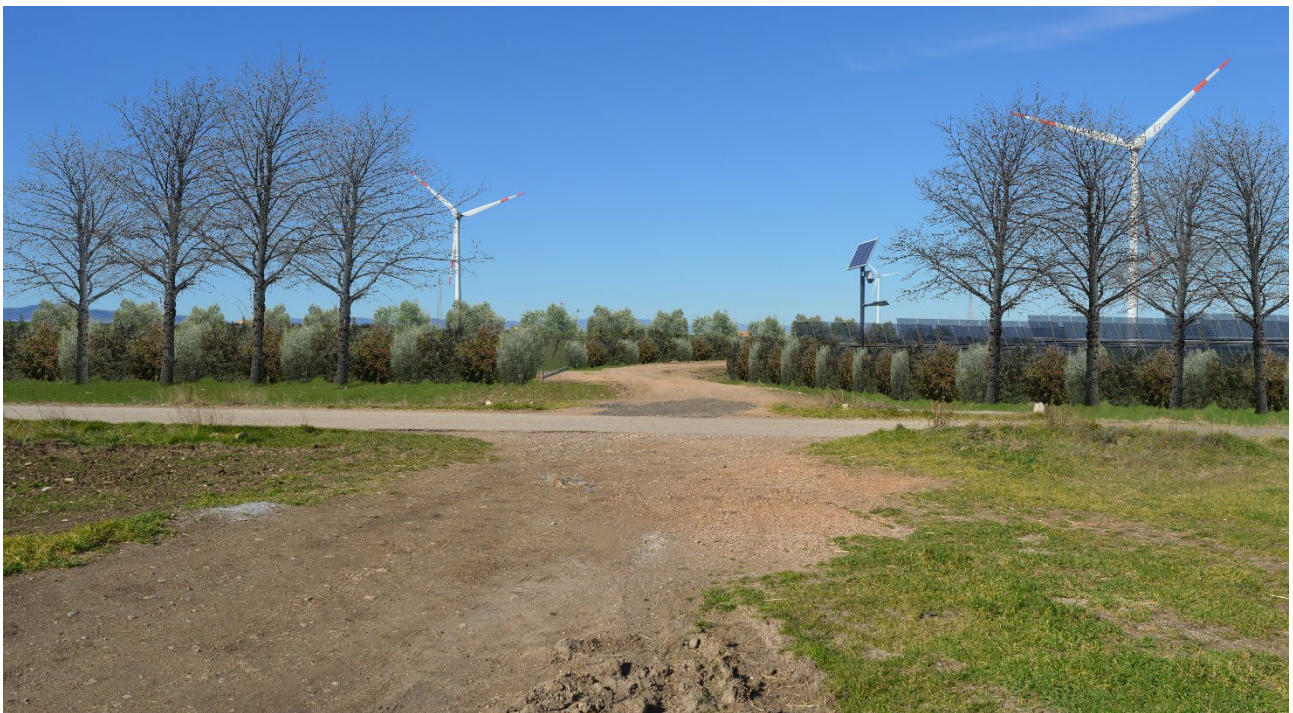
FS. 1 POST OPERAM- La foto mostra l'impianto agro-voltaico in esercizio, con le fasce di mitigazione suggerite dalla vegetazione spontanea di margine
