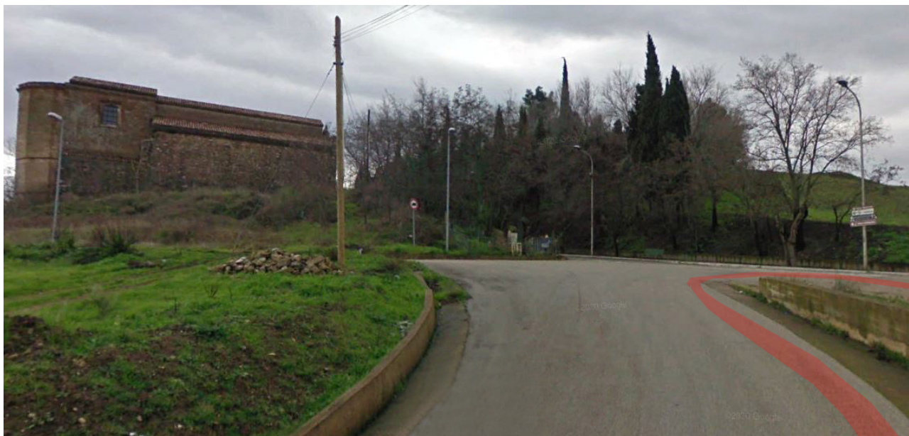
Figura 43 - Dalla foto si evince come il cavidotto, interrato sulla sede stradale asfaltata, non interferisca con le componenti del paesaggio tutelate, nel caso specifico il buffer Componenti culturali e insediative con buffer di 100m (D.Lgs 42/2004, art. 143, co1, lett.e), relativo alla Chiesa di S. Maria del Popolo
