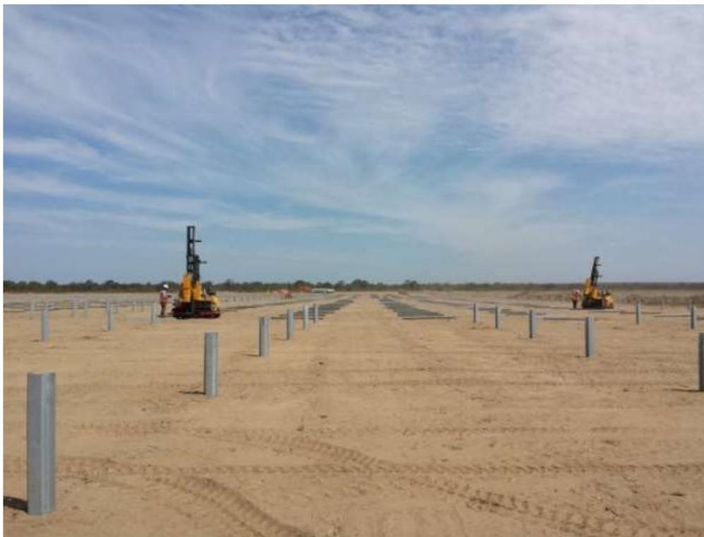
*Figura 16: Esempio di disposizione dei pali di fondazione delle strutture*
