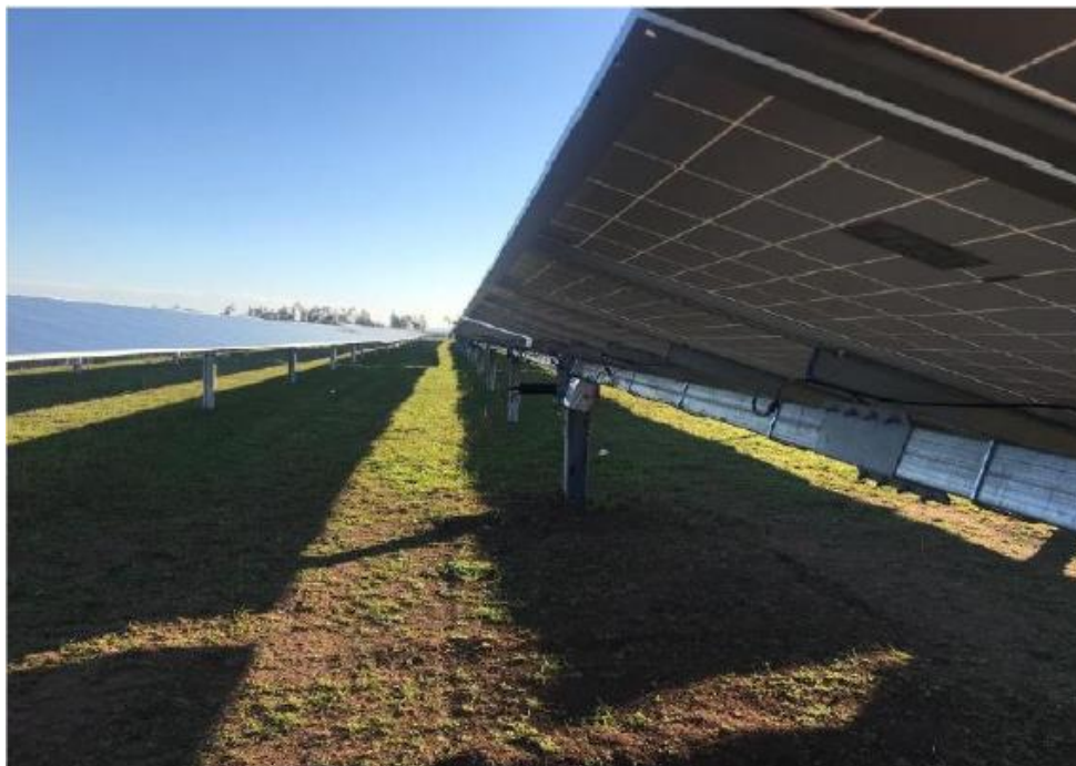
Figura 43. Esempio di impianto fotovoltaico realizzato con supporti costituiti da pali in acciaio infissi direttamente nel terreno
