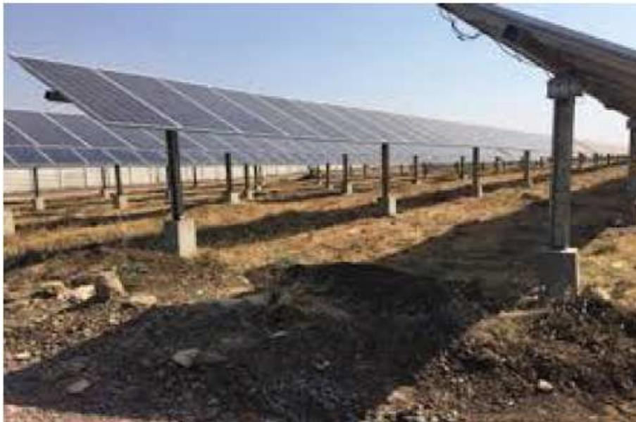
*Figura 7. Esempio di impianto fotovoltaico con fondazioni ottenute mediante perforazione del terreno e successiva creazione del palo di fondazione con getto di cemento.*
