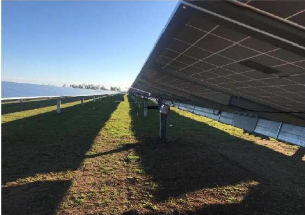
*Figura 6. Esempio di impianto fotovoltaico realizzato con supporti costituiti da pali in acciaio infissi direttamente nel terreno*
