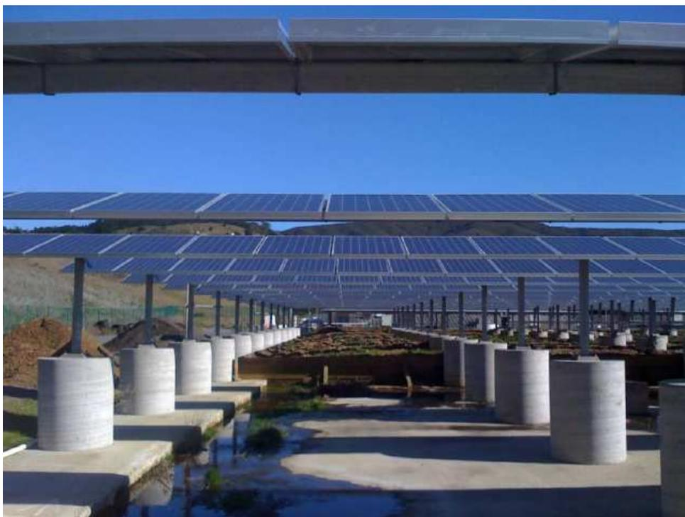
*Figura 8. Esempio di impianto fotovoltaico con fondazioni formate da zavorre costituite da plinti in cemento*
