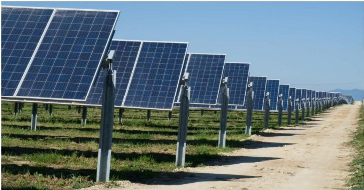
Figura 6-11 Allestimento dei pannelli su struttura tracker (Fonte: Relazione tecnica elettrica)
