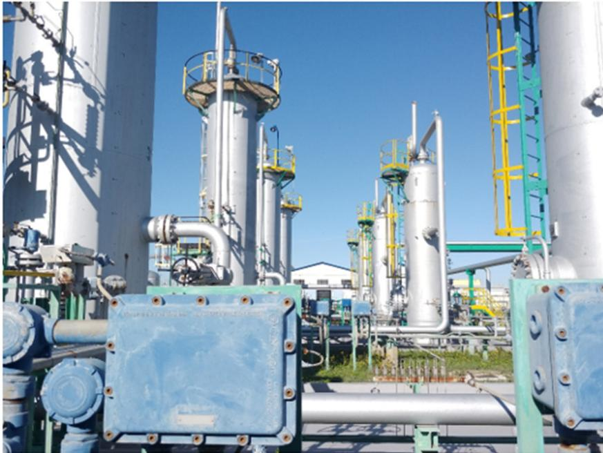
**Figura 3-10: Colonne di Disidratazione**
