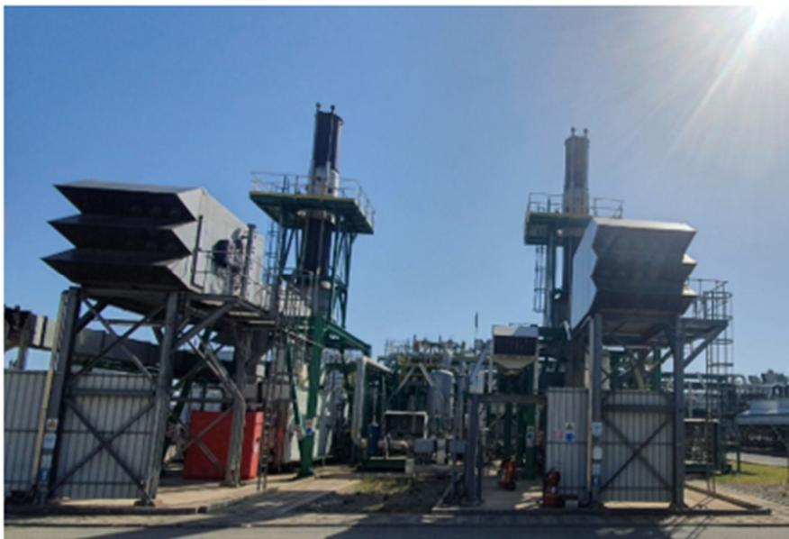
**Figura 3-6: Turbocompressori Alstom 1 (1° stadio) e Alstom 2 (2° stadio)**
