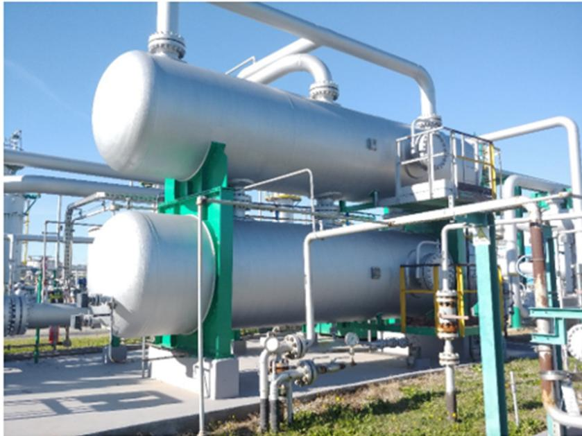
**Figura 3-5: Slug Catcher SC-1 della Centrale Gas Crotono**
