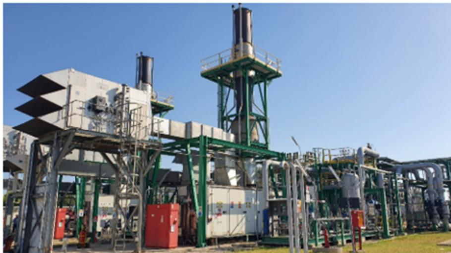
Figura 3-7: Turbocompressore Alstom 2 (2° stadio), denominato "Treno 2" (360-2KA-001)
