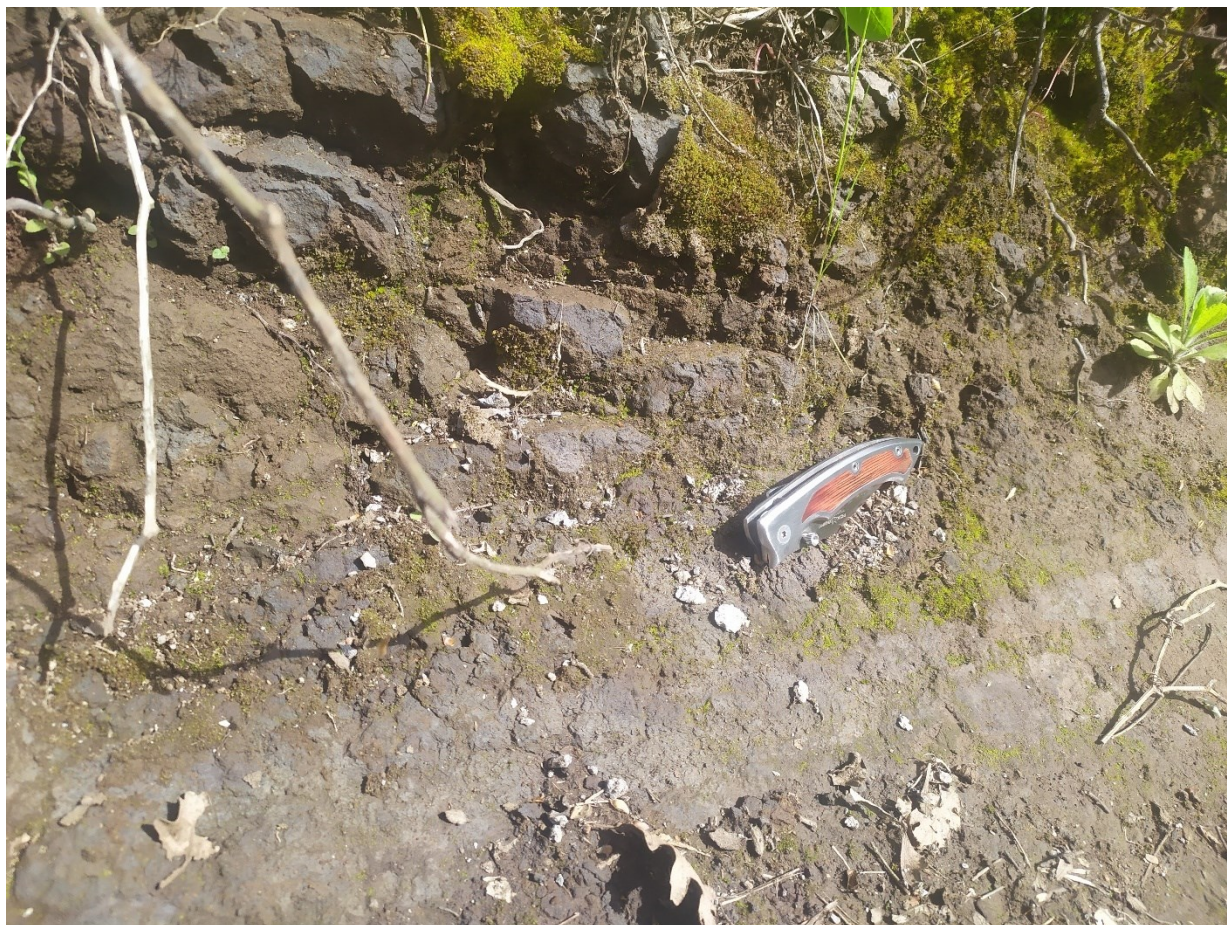
Figura 18: Profilo di alterazione dei Basalti della Subunità di Sindia lungo la strada di accesso alla WTG M1_12. Coordinate 470307.92 m E-4448731.99 m N. l'alterazione chimica è piuttosto profonda e ha causato la perdita della consistenza litoide dell'orizzonte superficiale in affioramento, che risulta sostanzialmente friabile.
