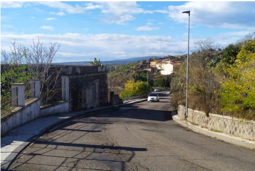
Figura 130 - Post-operam: Visuale del Punto di ripresa PV6 verso le WTG di progetto (Coordinate: 481523.00 m E; 4457136.00 m N)
