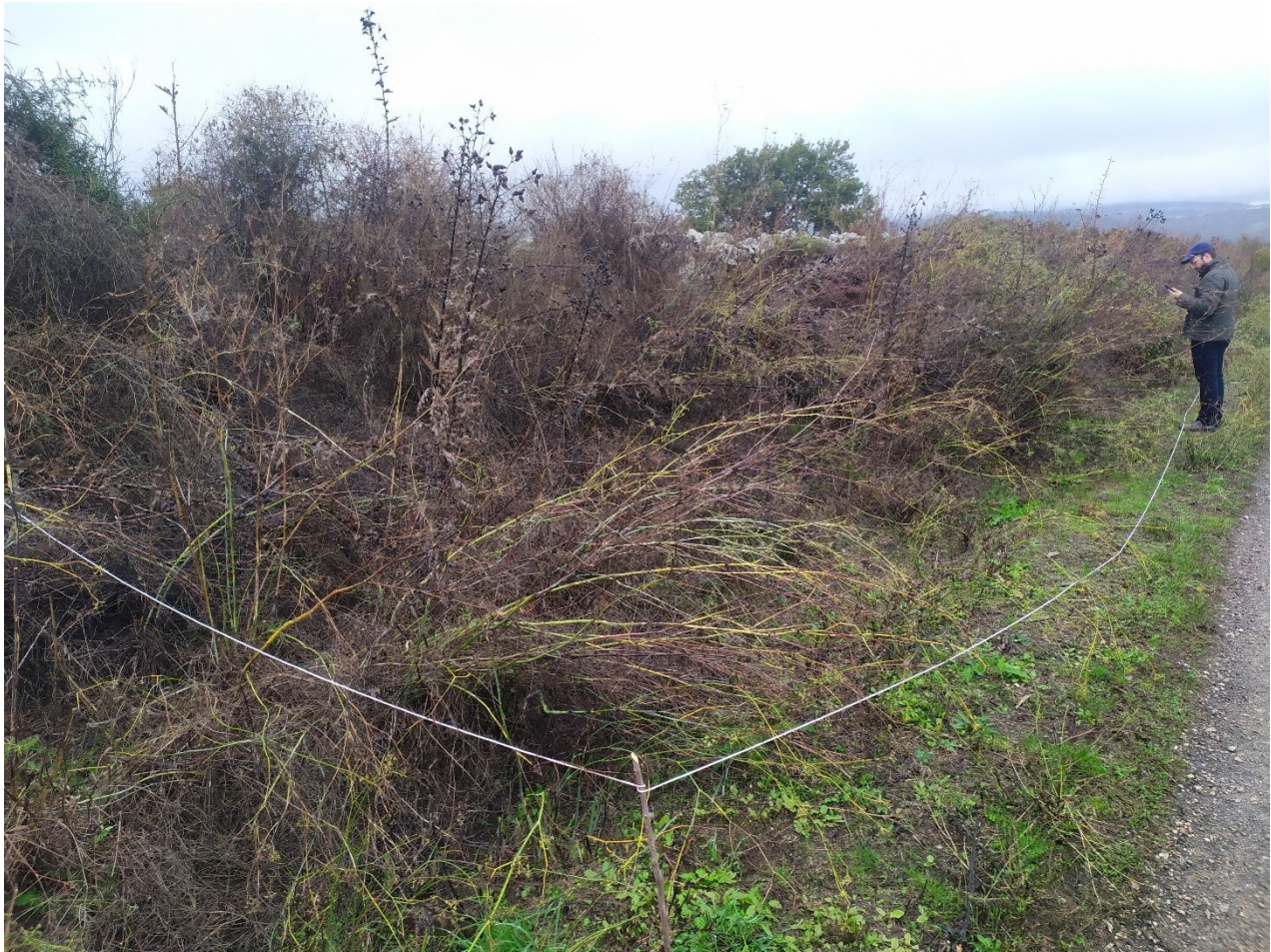
Figura 7-Area rilievo S1, in prossimità del punto di posa del cavidotto per la connessione della WTG5.
