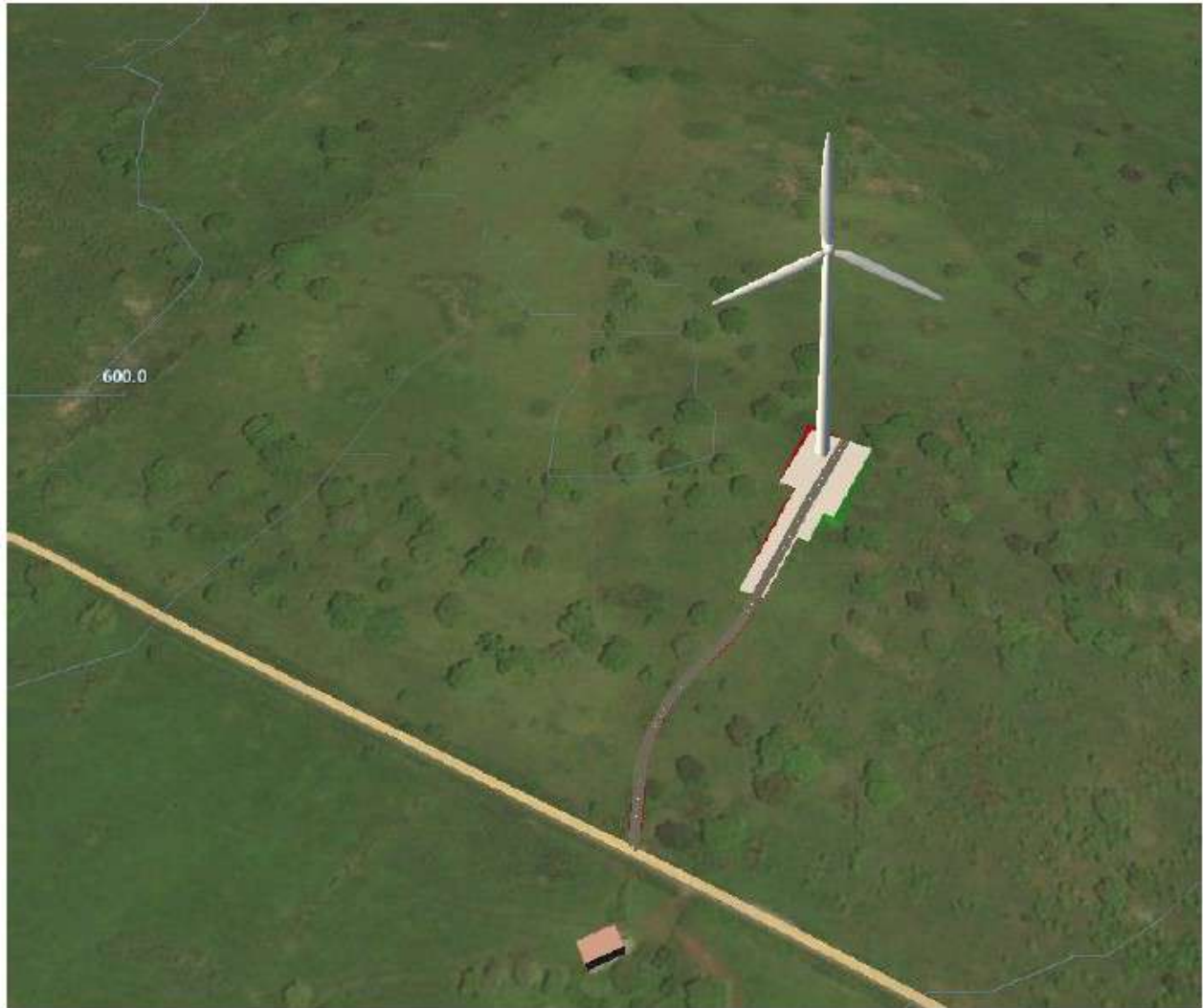
Figura 78 - Viabilità di accesso alla WTG M2_13
