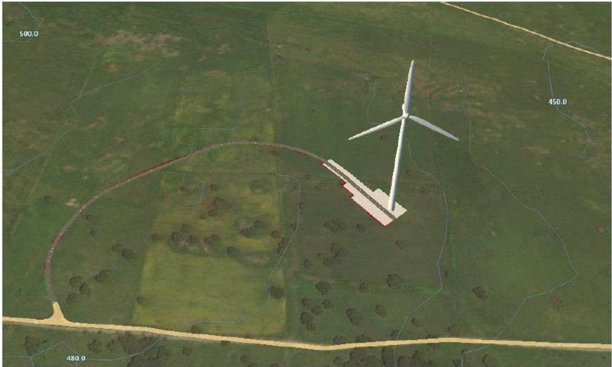
Figura 79 - Viabilità di accesso alla WTG M2_15
