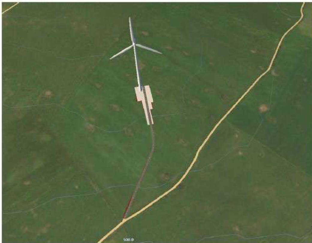
Figura 77 - Viabilità di accesso alla WTG M2_12
