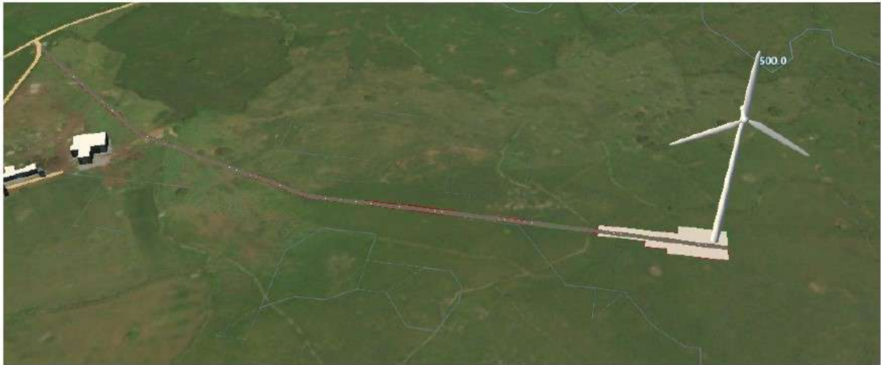
Figura 76 - Viabilità di accesso alla WTG M2_11
