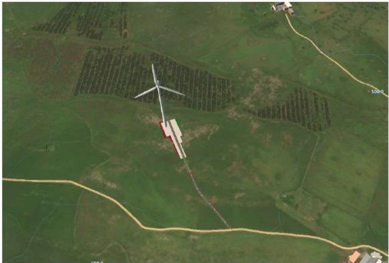
Figura 74 - Viabilità di accesso alla WTG M2_09
