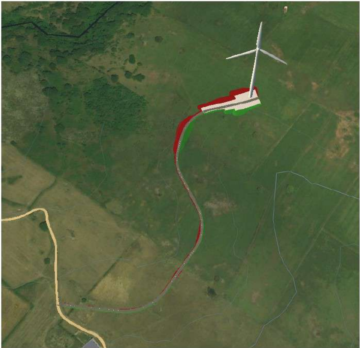
Figura 72 - Viabilità di accesso alla WTG M2_05
