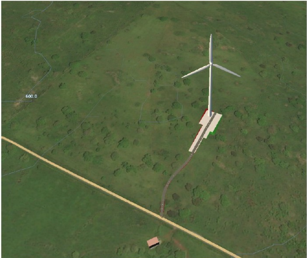
Figura 18 - Viabilità di accesso alla WTG M2_13
