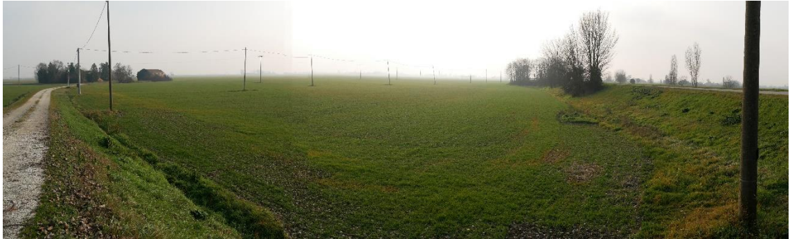
Figura 4.10: Panoramica dell'area di intervento
