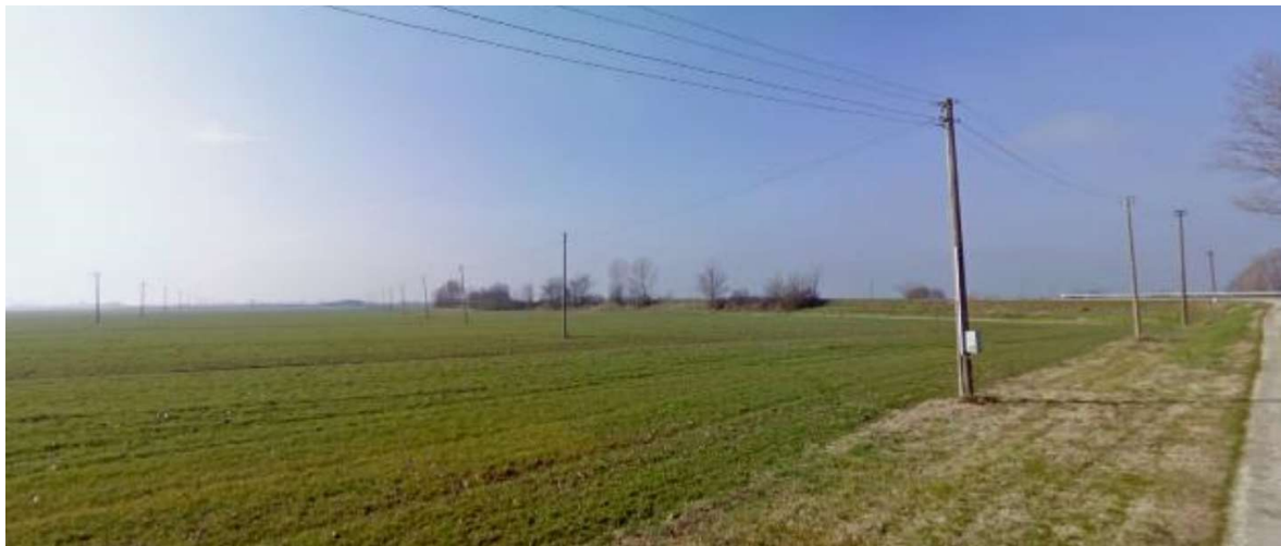
Figura 2.3: Panoramica delle linee elettriche in Bassa tensione in direzione Nord-Est-Ovest.
