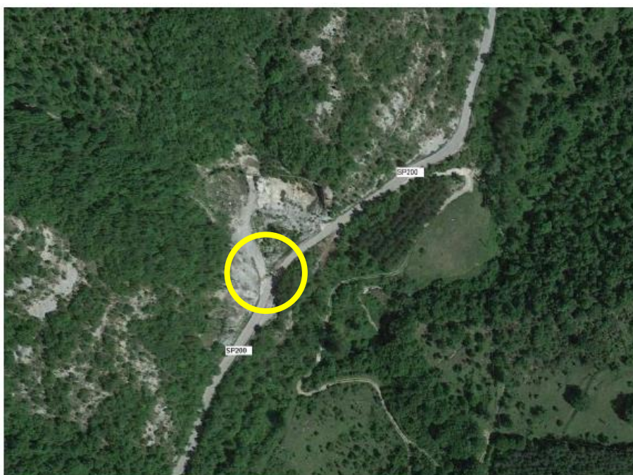
Figura 10– Imbocco della Guinza lato Parnacciano – Vista dall’alto
