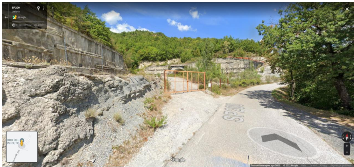
Figura 9– Imbocco della Guinza lato Parnacciano – Vista dalla SP200
