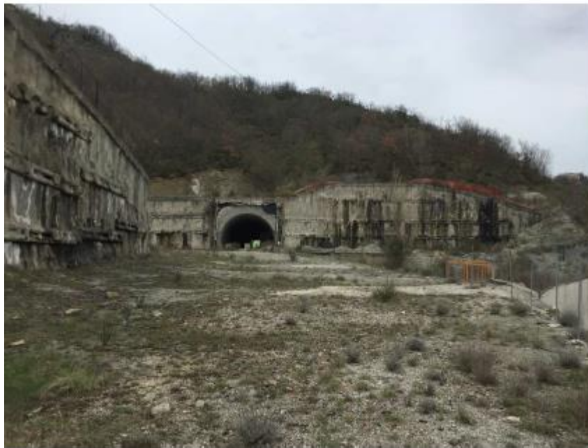
Figura 8– Imbocco della Guinza lato Parnacciano – Area di cantiere, ingresso galleria e paratie
