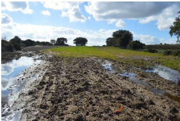
Figura 116 - WTG02, sito di realizzazione della piazzola permanente, vista N → S
