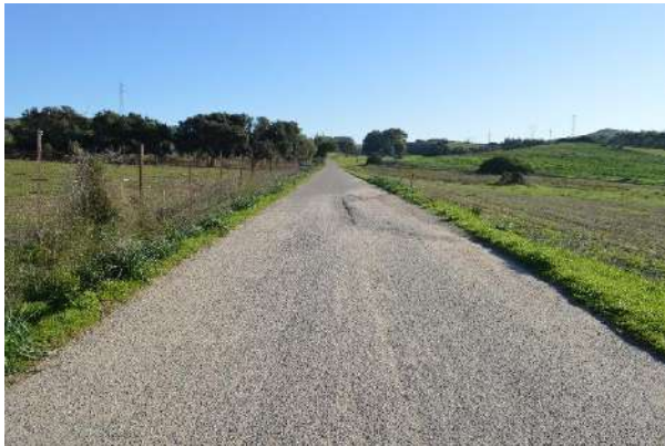
Figura 130 – Strada asfaltata esistente
