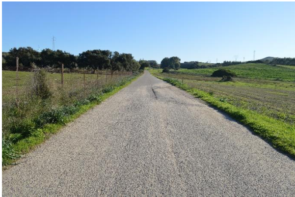
Figura 48 – Strada asfaltata esistente
