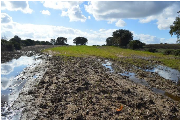
Figura 34 - WTG02, sito di realizzazione della piazzola permanente, vista N → S
