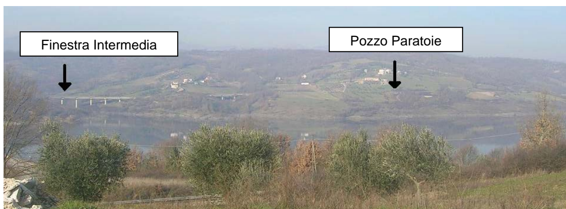
Figura 5.n: Vista Accesso Finestra Intermedia e Pozzo Paratoie
