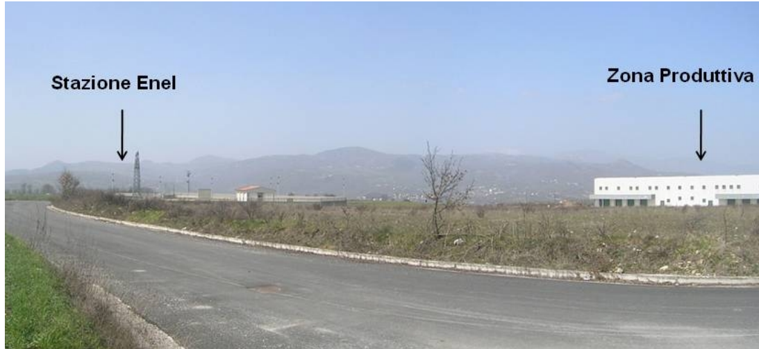
Figura 5.s: Vista da Sud-Est del sito di realizzazione della Stazione di Pontelandolfo
