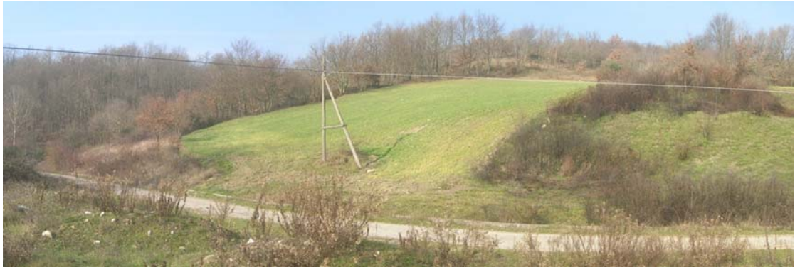
Figura 3.m: Vista dell'area di Accesso alla Finestra Intermedia
