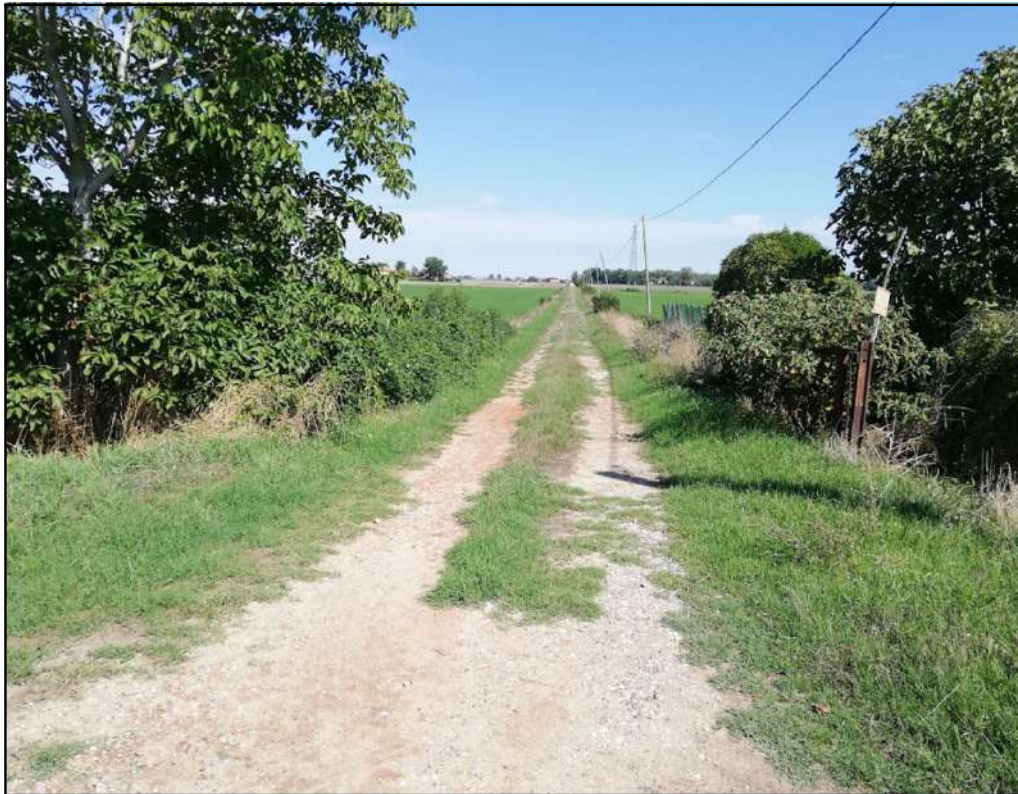
Strada non idonea lato nord
