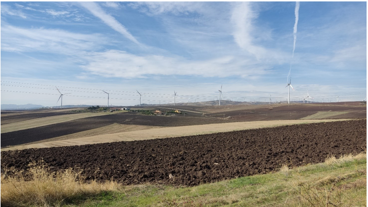
Punto di presa n° 32 - Stato di Fatto
