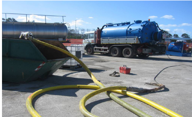
Figura 3-9: Lavaggio ombelicali con acqua in pressione mediante autospurgo
