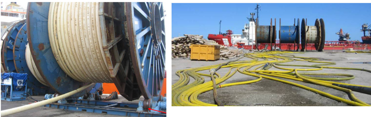
Figura 3-6: Srotolamento riser (a sinistra) e ombelicali (a destra) e predisposizione ombelicali al lavaggio
