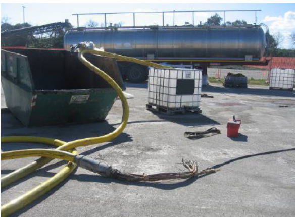
Figura 3-9: Lavaggio ombelicali con acqua in pressione mediante autospurgo
