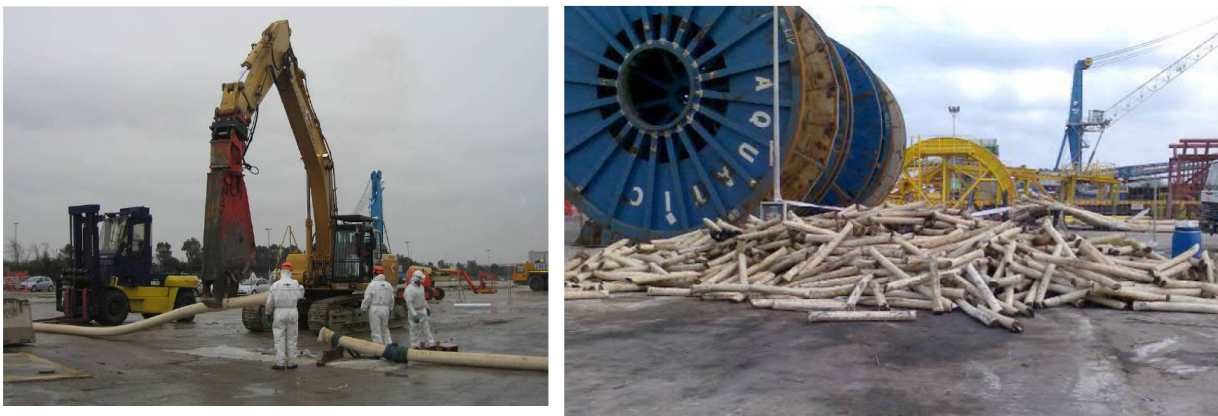
Figura 3-7: Taglio riser (a sinistra) con cesoia idraulica (su teli in PE e con sigillatura delle estremità tagliate). A destra risers ridotti ad appezzatura idonea allo smaltimento
