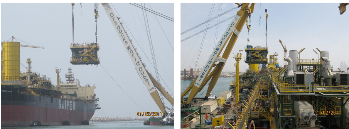
Figura 3-11: Fasi dell'attività di conversione della petroliera Betatank in Firenze FPSO
