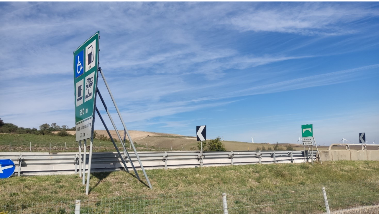
Punto di presa n° 22 - Stato di Fatto
