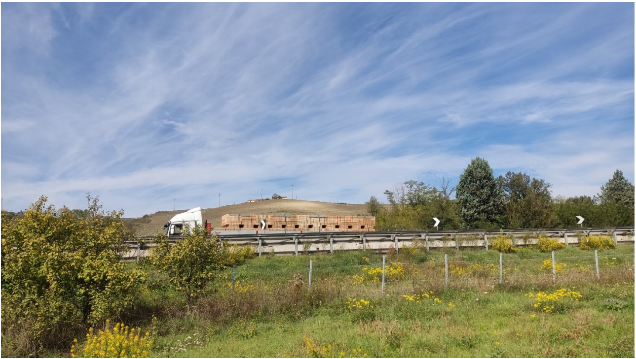
Punto di presa n° 39 - Stato di Fatto
