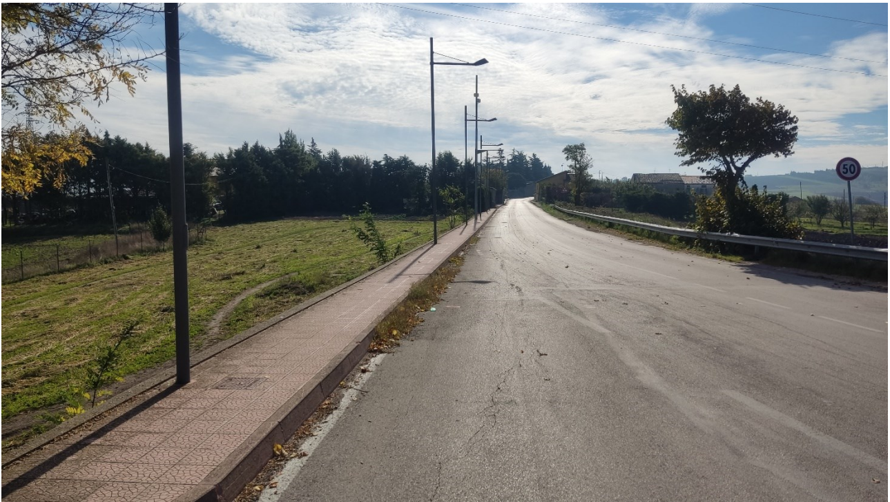
Punto di presa n° 17 - Stato di Fatto
