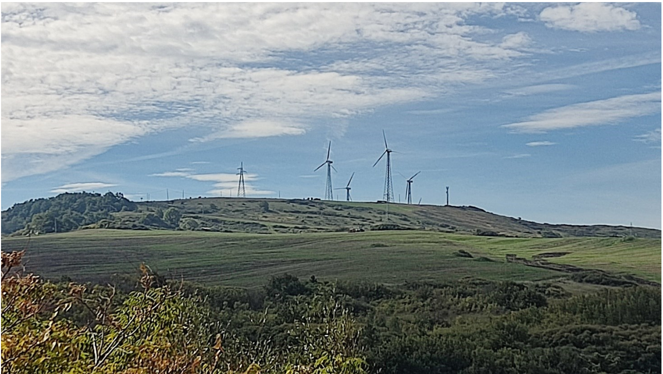
Punto di presa n° 2 - Stato di Fatto
