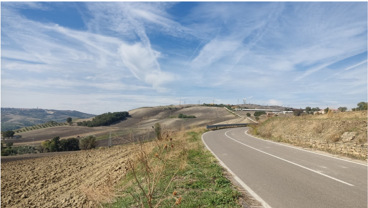
Punto di presa n° 40 - Stato di Fatto
