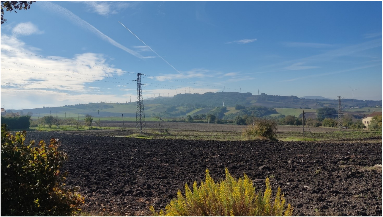
Punto di presa n° 11 - Stato di Fatto
