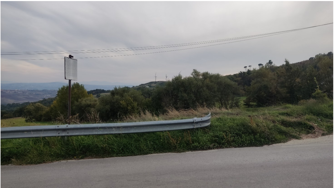
Punto di presa n° 13 - Stato di Fatto
