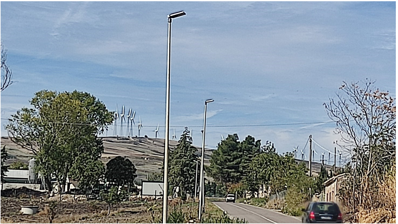
Punto di presa n° 29 - Stato di Fatto
