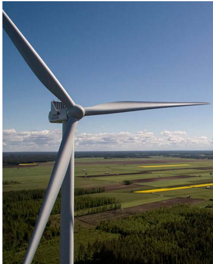
Fig. 4. Un aerogeneratore VESTAS V136 in esercizio
