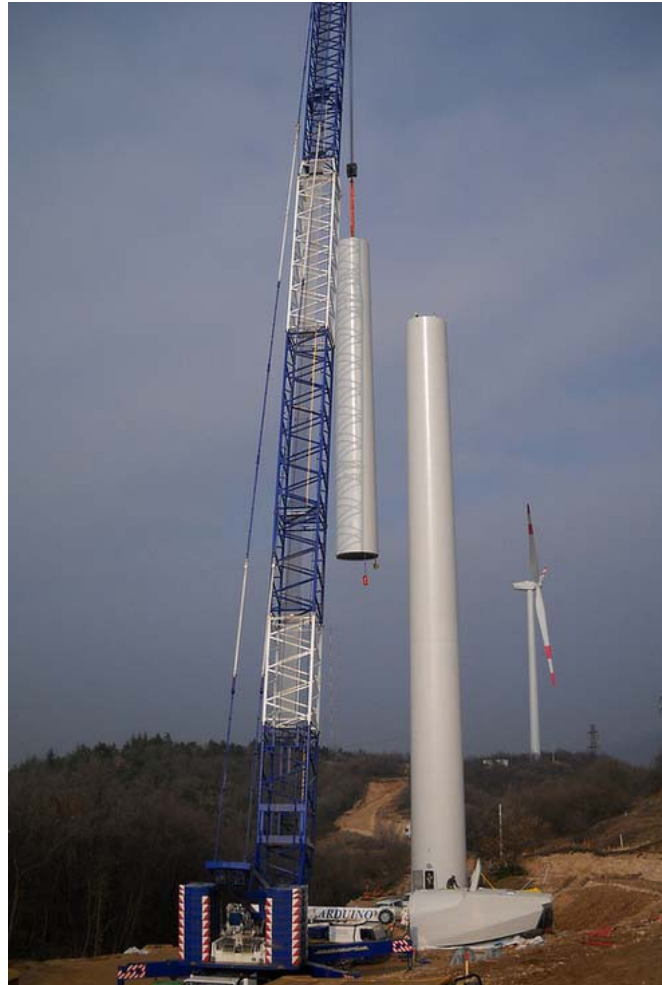
Fig. 13. Operazione di montaggio di una torre eolica.
