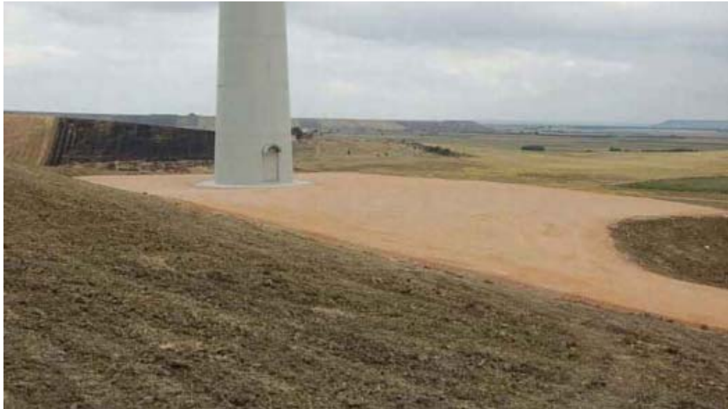
Fig. 12. Sistemazione finale di una piazzola-tipo di un aerogeneratore
