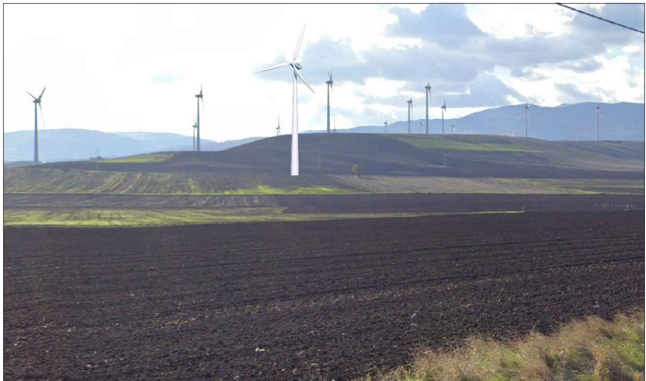
FIGURA 19 – Vista panoramica Aerogeneratore (WTG 2)
