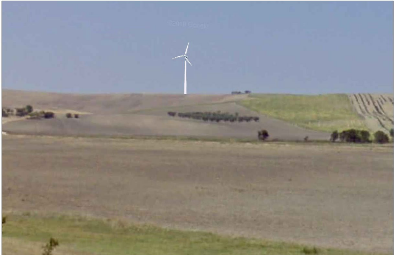
FIGURA 26 – Vista panoramica Aerogeneratore (WTG 9)
