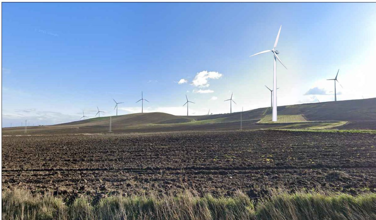
FIGURA 21 – Vista panoramica Aerogeneratore (WTG 4)
