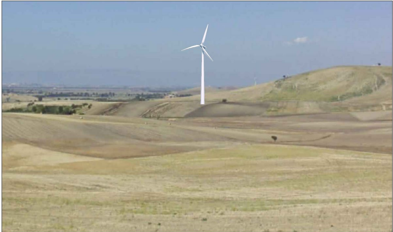
FIGURA 22 – Vista panoramica Aerogeneratore (WTG 5)
