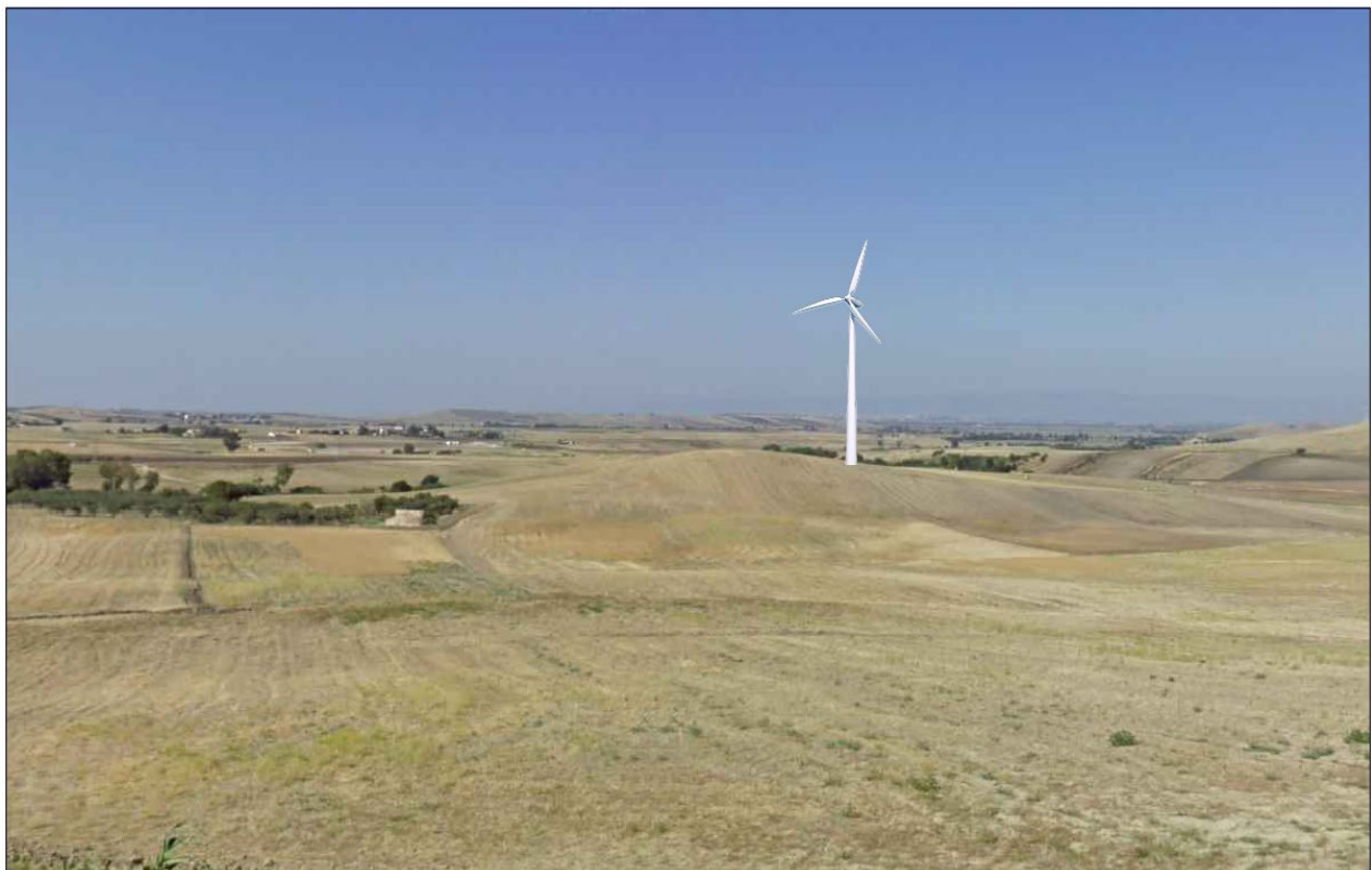
FIGURA 23 – Vista panoramica Aerogeneratore (WTG 6)
