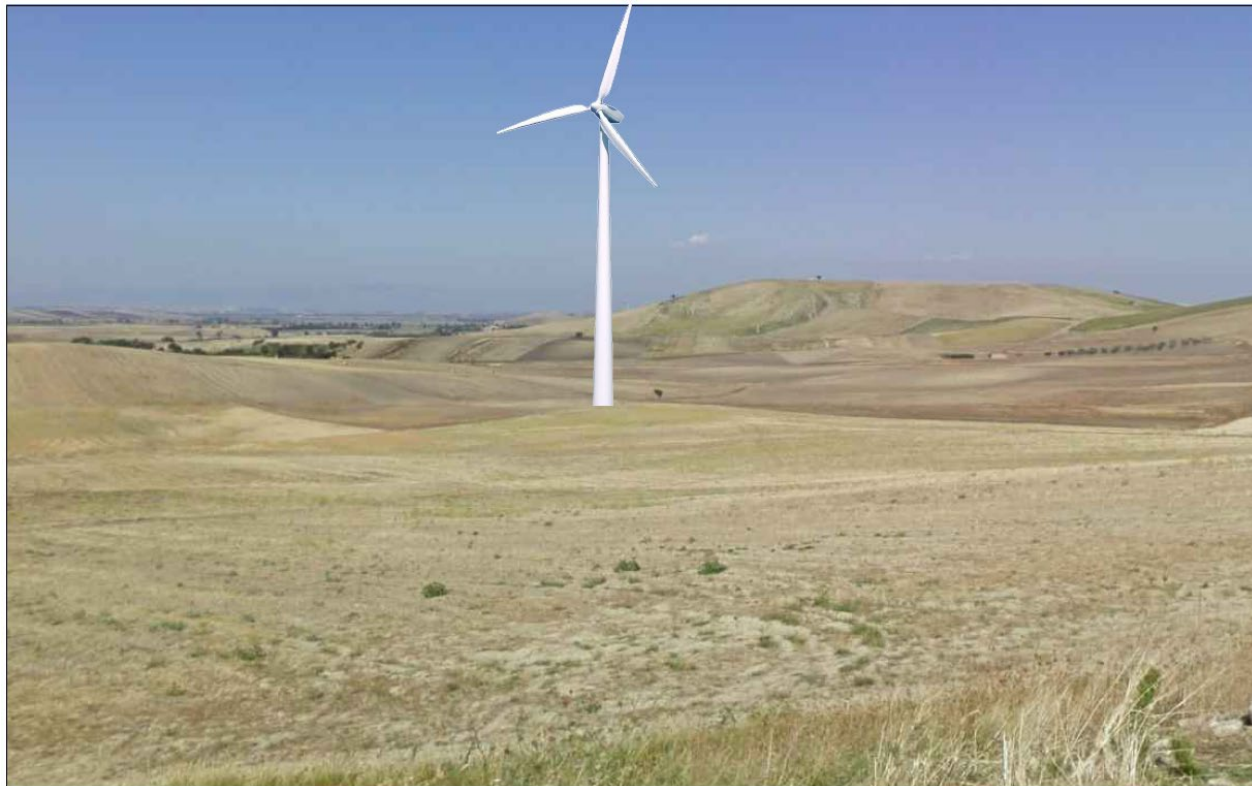
FIGURA 24 – Vista panoramica Aerogeneratore (WTG 7)
