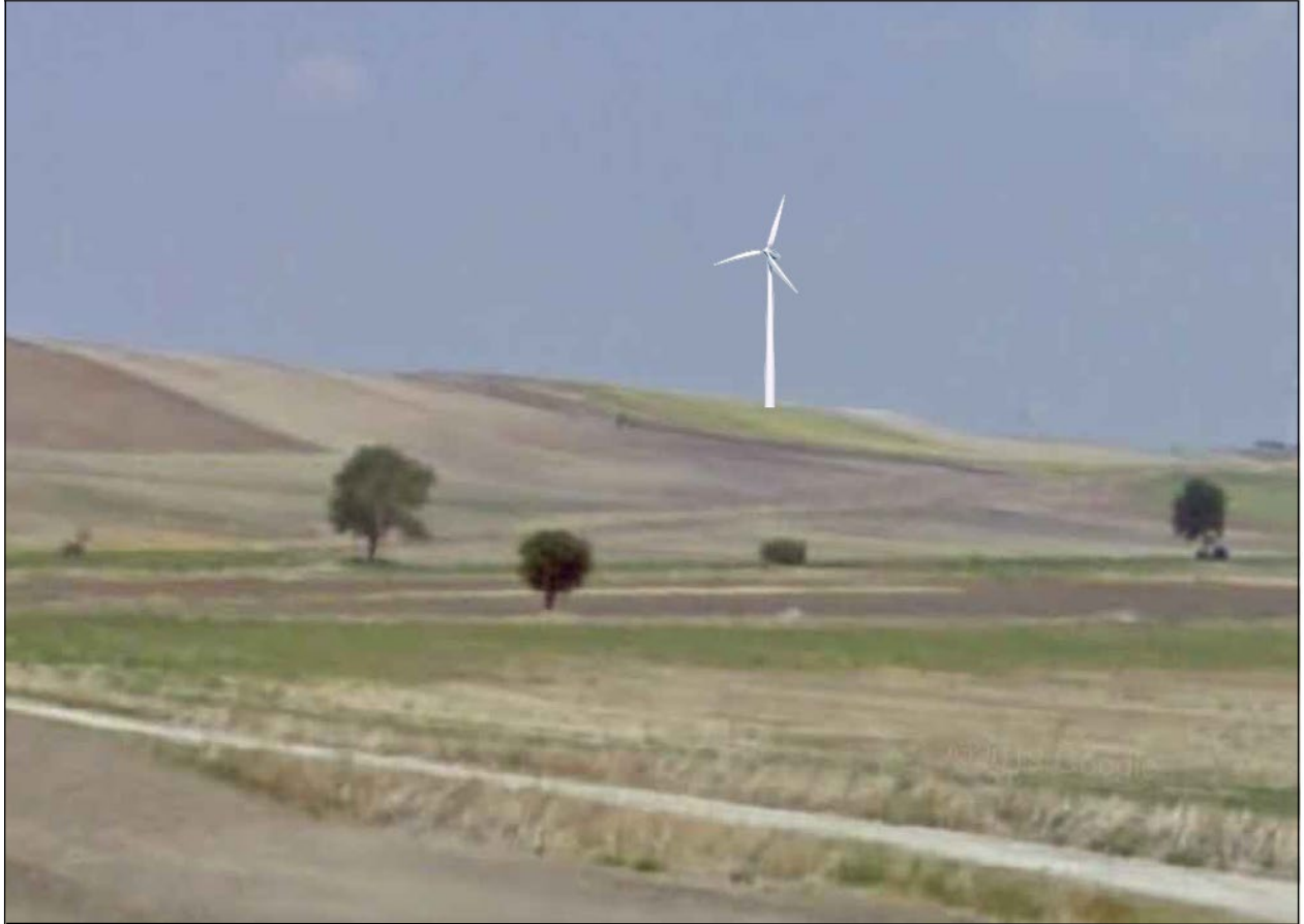
FIGURA 28 – Vista panoramica Aerogeneratore (WTG 11)
