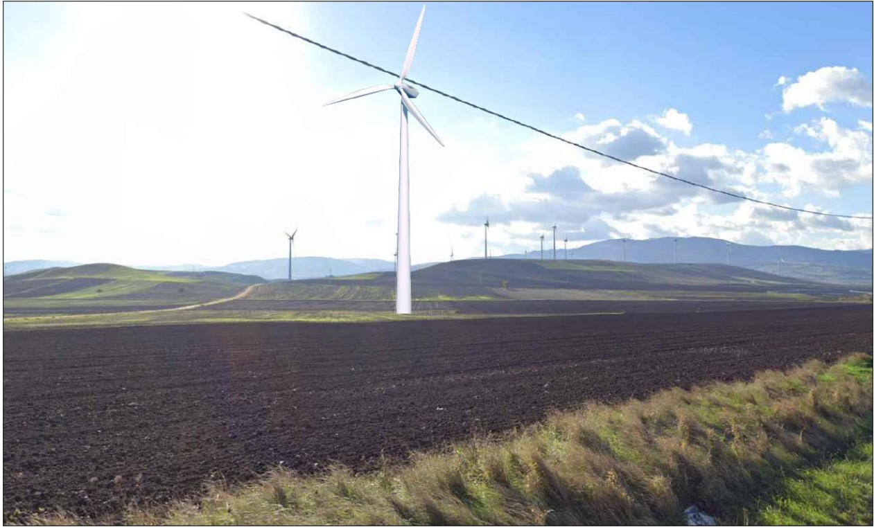
FIGURA 18 – Vista panoramica Aerogeneratore (WTG 1)
