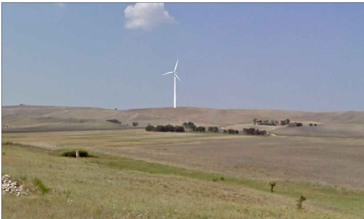
FIGURA 25 – Vista panoramica Aerogeneratore (WTG 8)
