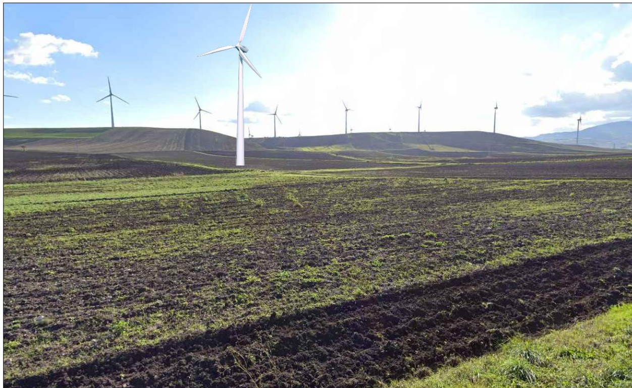
FIGURA 20 – Vista panoramica Aerogeneratore (WTG 3)
