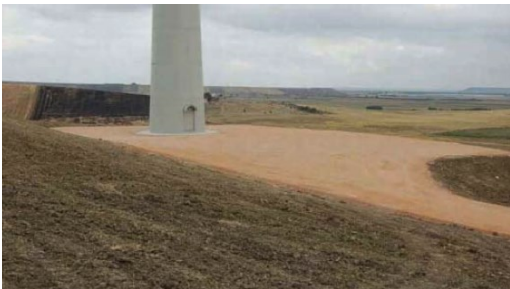
Figura 6.9. – Sistemazione finale di una piazzola-tipo di un aerogeneratore.
