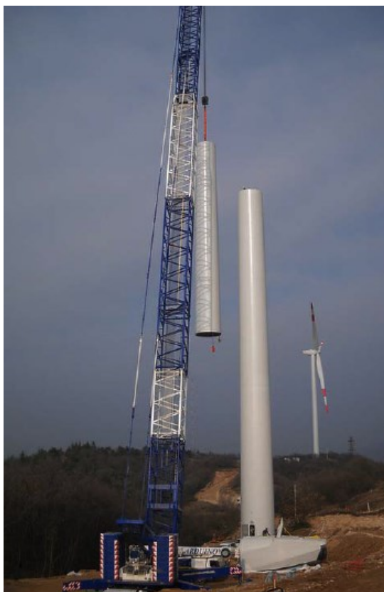
Figura 6.10. – Operazione di montaggio di una torre eolica.
