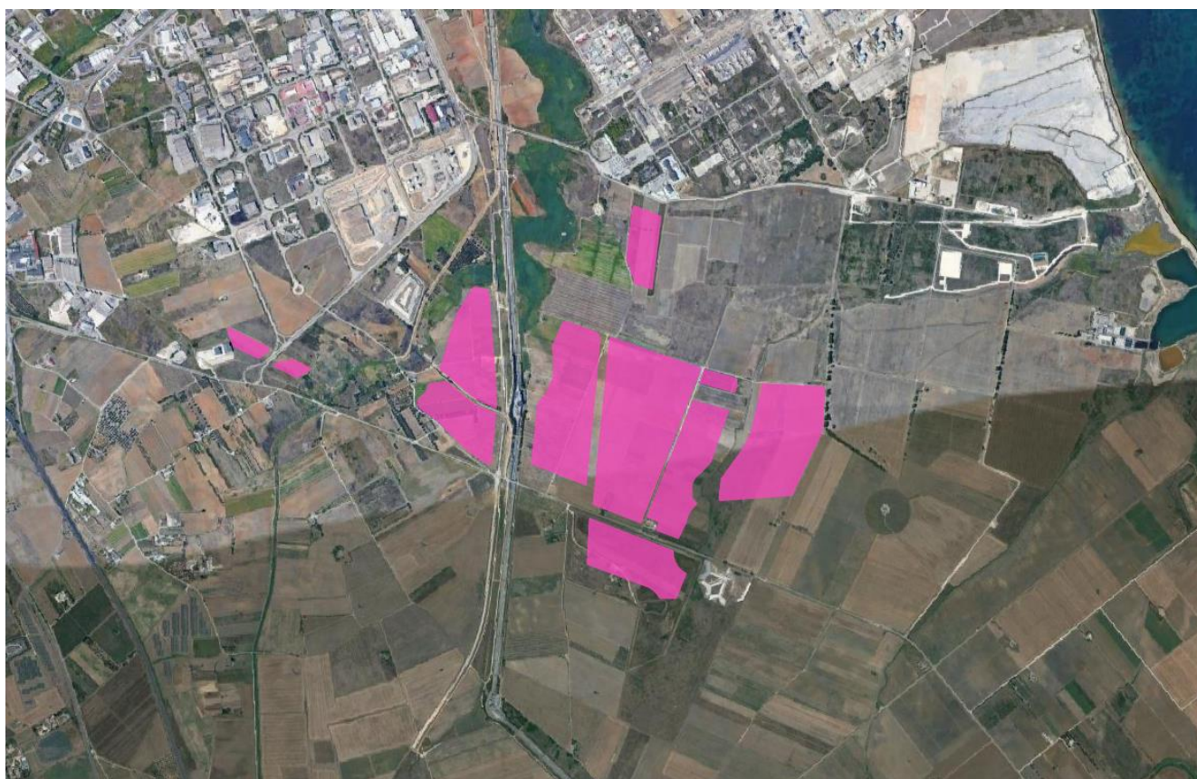
Figura 11: Ortofoto con vista dell'impianto fotovoltaico
