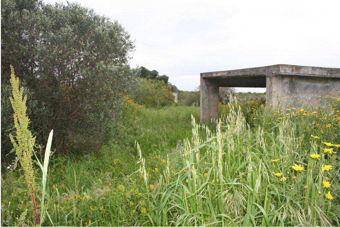
33 – Brindisi (BR), UR 8 panoramica dell'area destinata al primo segmento di cavidotto in direzione SO
