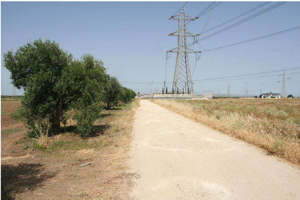
54 – Brindisi (BR), UR 10 panoramica del segmento di cavidotto in direzione O lungo la la Strada Comunale 69
