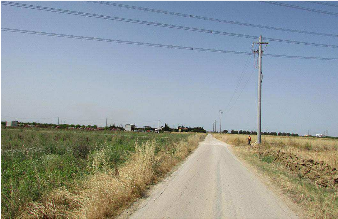
51 – Brindisi (BR), UR 10 panoramica del segmento di cavidotto in direzione S lungo lungo Contrada Muscia in prossimità dell'incrocio con Strada Comunale 69
