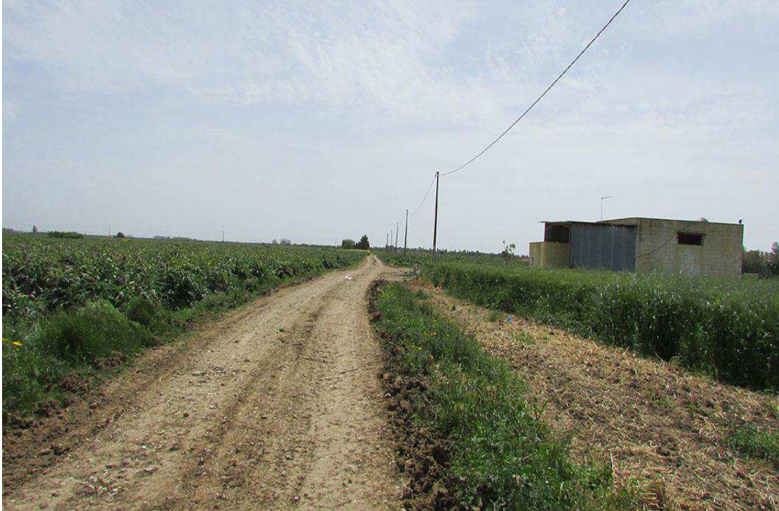
37 – Brindisi (BR), UR 8 panoramica del segmento di cavidotto in direzione S nel tratto che costeggia l'UR 7 Area a bosco lungo la SC 78
