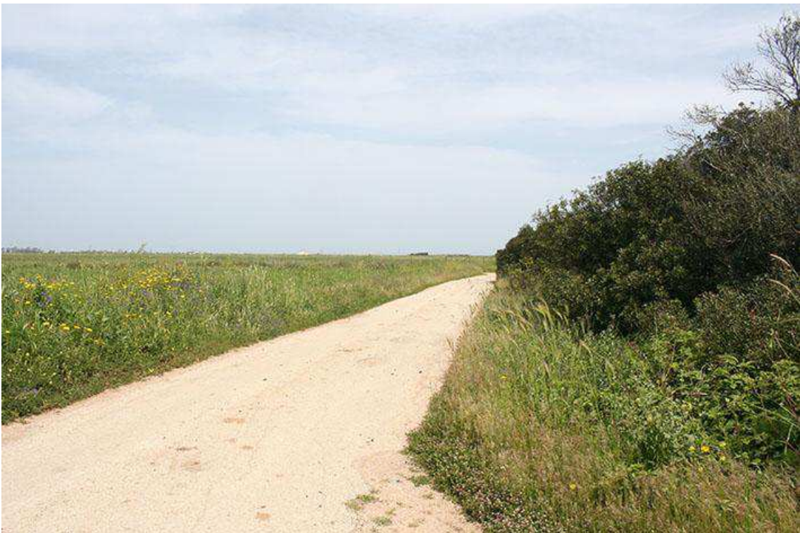
40 – Brindisi (BR), UR 9 panoramica del segmento di cavidotto in direzione N nel primo tratto lungo la SC 31
