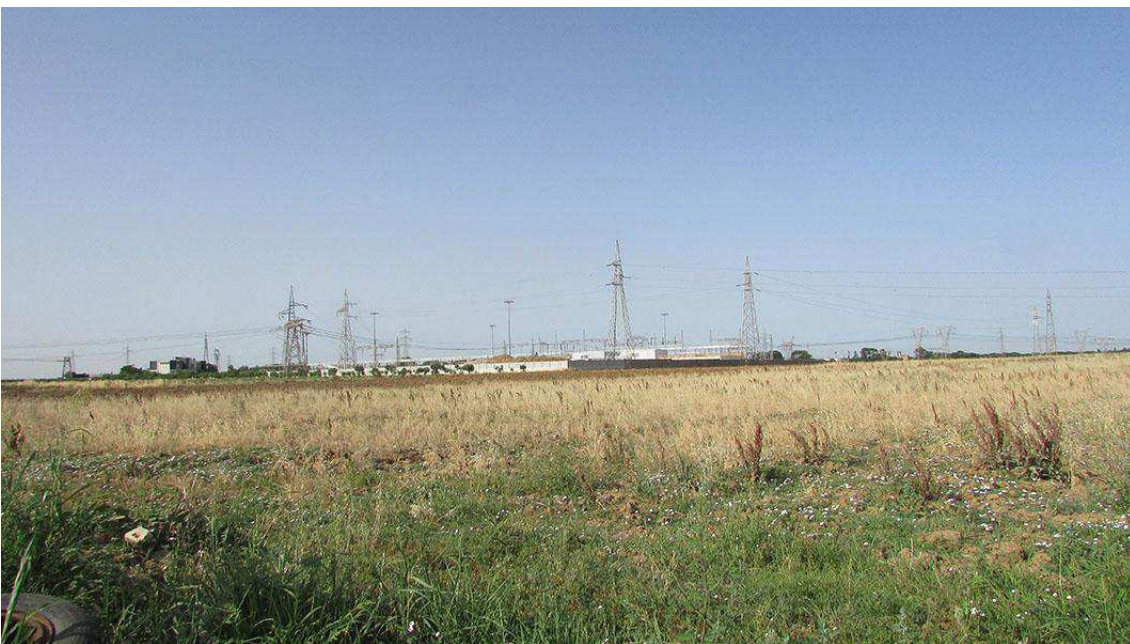
Brindisi (BR), a NO di loc. Palmarini, panoramica dell'ultimo tratto del segmento di cavidotto dell'UR 10 in corrispondenza della stazione di consegna
