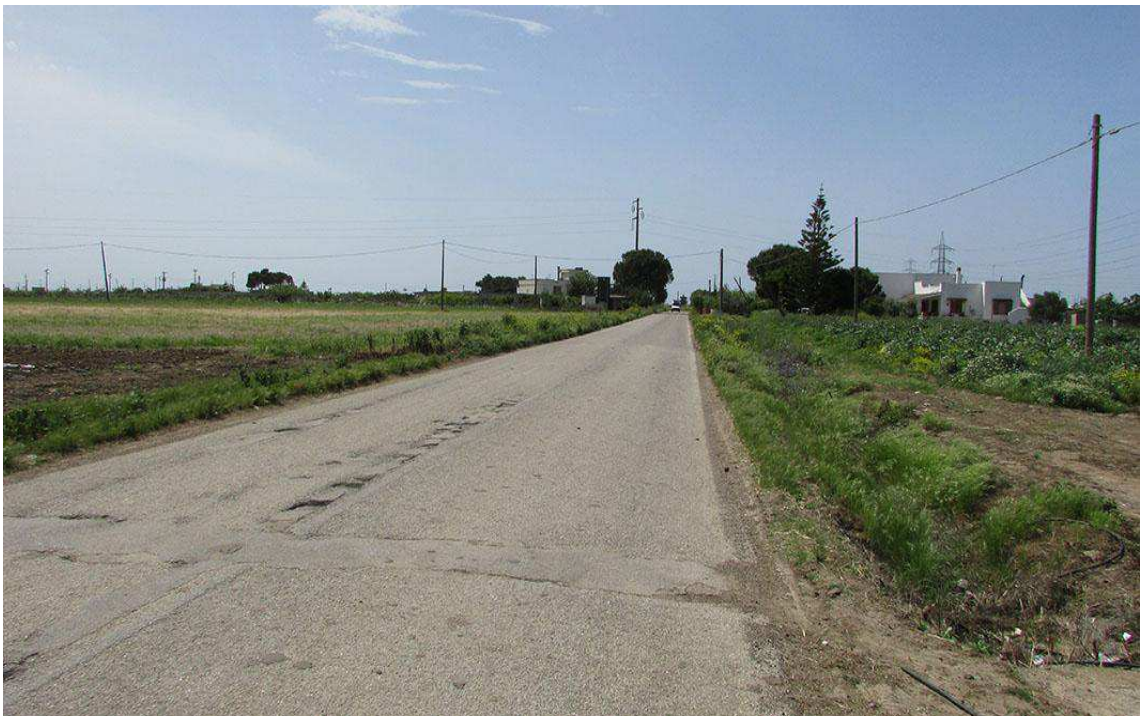
46 – Brindisi (BR), UR 9, loc. Boccardi, panoramica del segmento di cavidotto in direzione O lungo la SP 43
