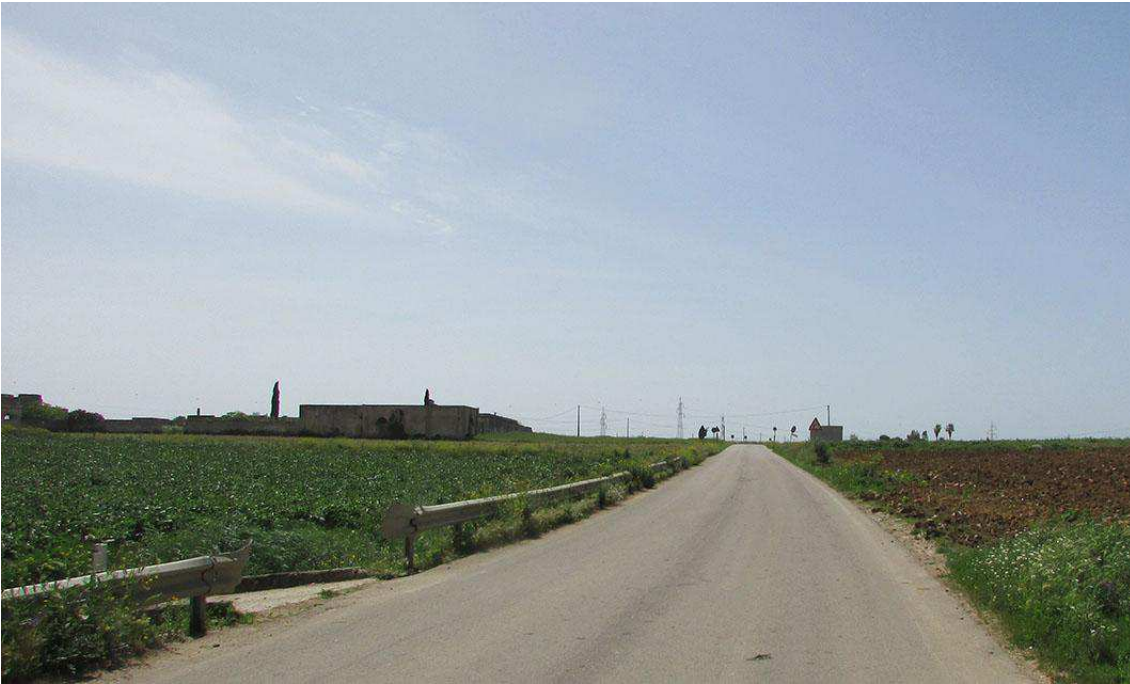
Brindisi (BR), loc. Palmarini, panoramica del segmento di cavidotto dell'UR 10 corrente su SP 43 in corrispondenza di Mass. Palmarini
