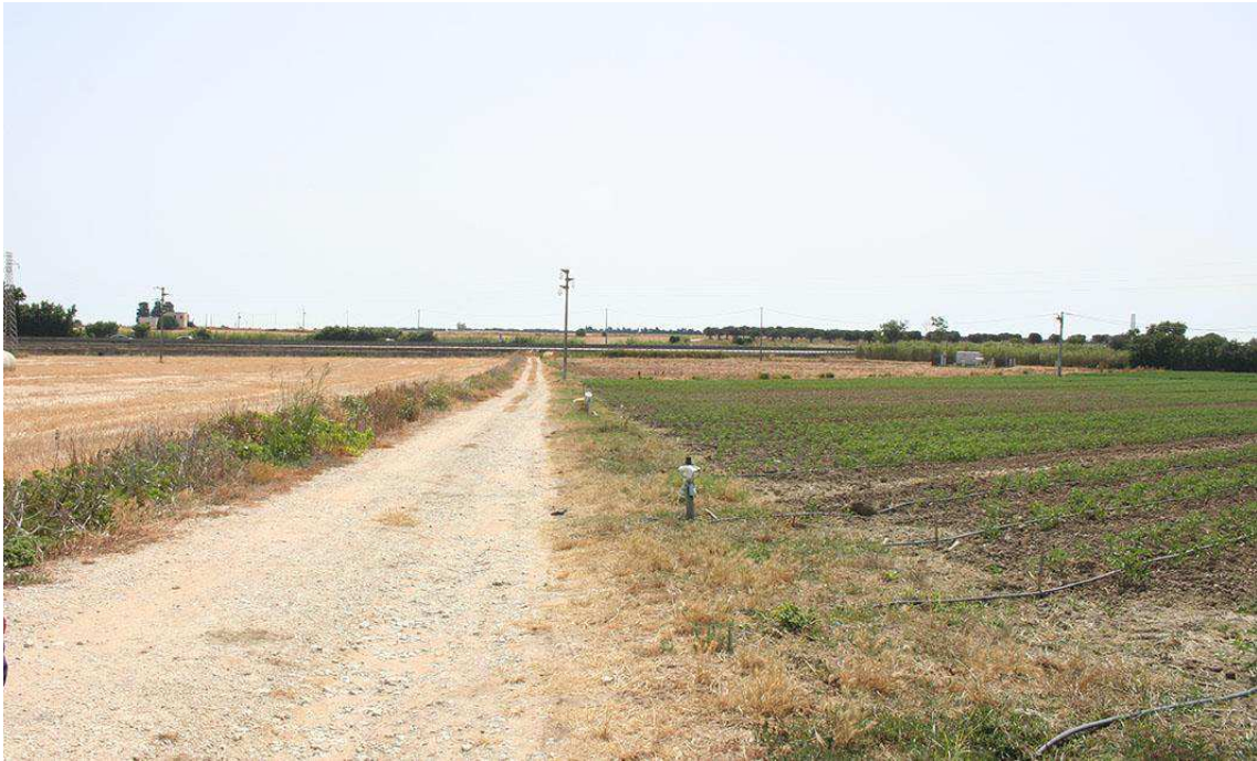
Brindisi (BR), UR 9, Mass. Taverna, segmento di cavidotto su strada interpodereale, panoramica in direzione NE
