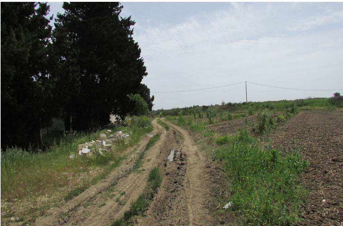
38 – Brindisi (BR), UR 8 panoramica del segmento di cavidotto in direzione S lungo la SC 78
