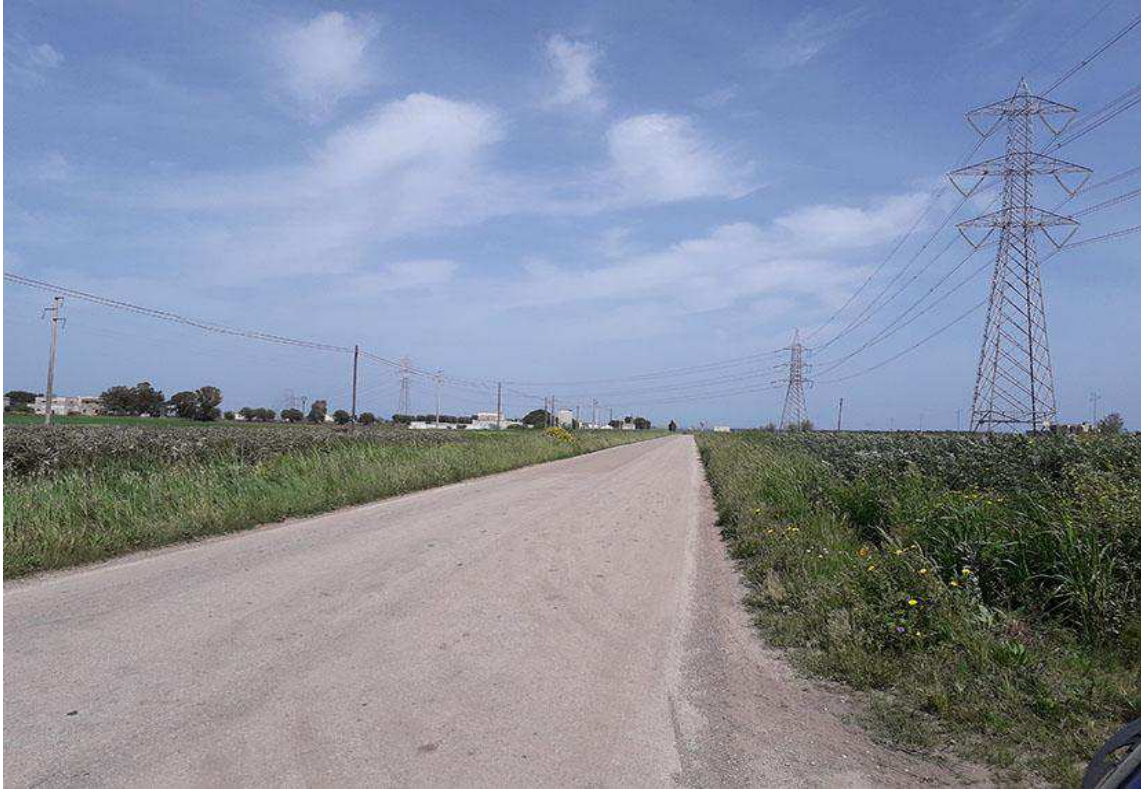
45 – Brindisi (BR), UR 9 panoramica del segmento di cavidotto in direzione E, verso Mass. Palmenti lungo la SP 43
