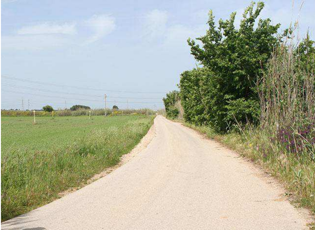
43 – Brindisi (BR), UR 9 panoramica del segmento di cavidotto in direzione O lungo la Strada Comunale Formosa verso la SC 80
