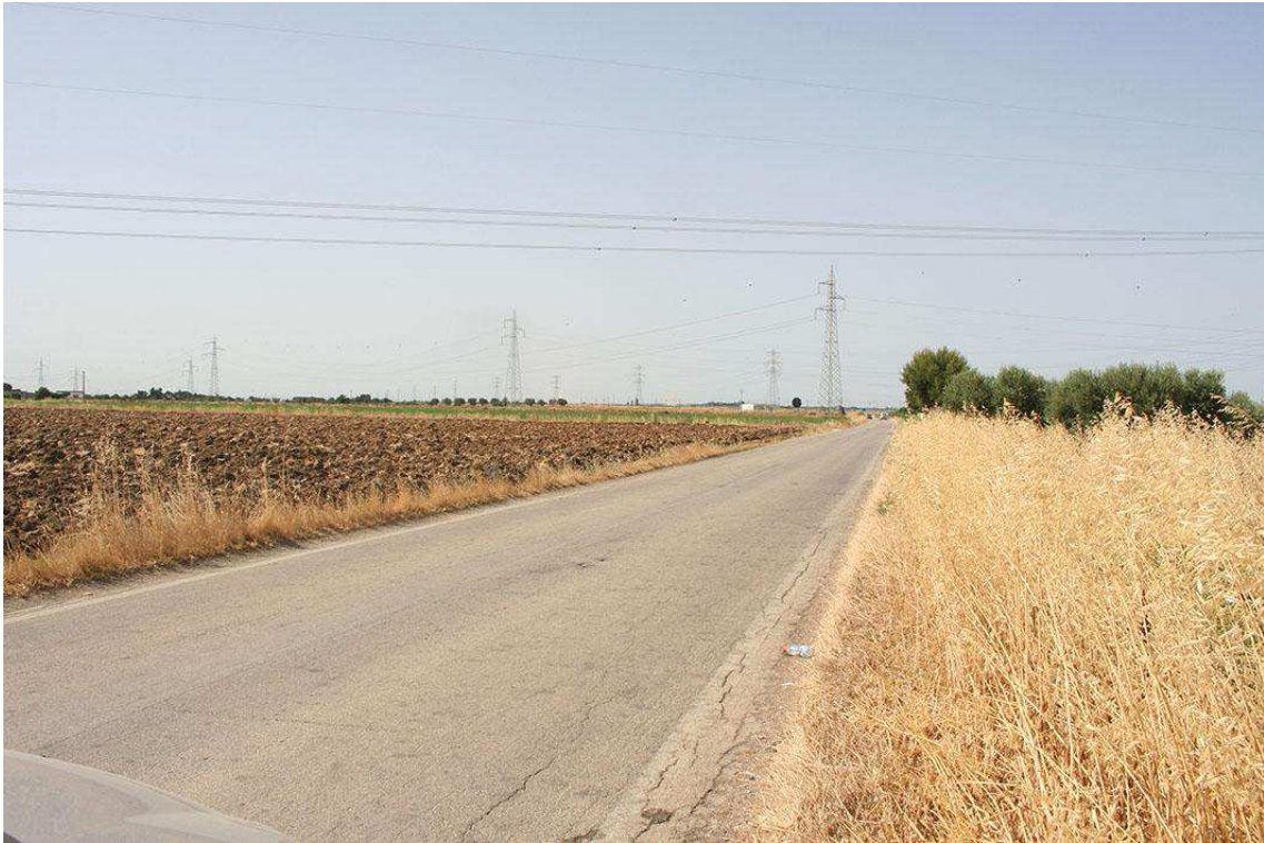
55 – Brindisi (BR), UR 10 panoramica del segmento di cavidotto in direzione O lungo la Strada per S. Donaci
