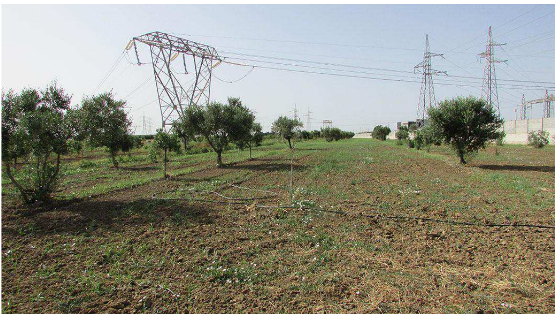
Brindisi (BR), UR 10, ultimo tratto del cavidotto presso Stazione terna, panoramica in direzione E
