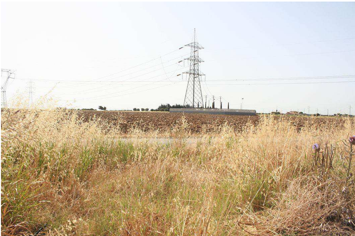
56 – Brindisi (BR), UR 10 panoramica del segmento di cavidotto in direzione E lungo l'attraversamento di campi coltivati tra la Strada per S. Donaci e la Strada per Schiavoni
