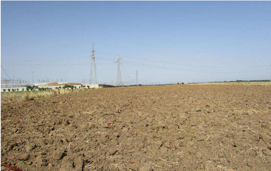
59 – Brindisi (BR), UR 10 panoramica del segmento di cavidotto in direzione O verso la Stazione elettrica Terna
