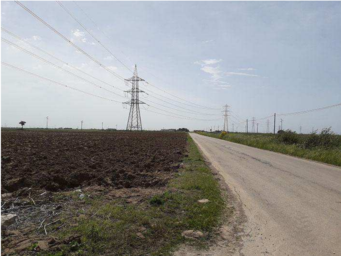
Brindisi (BR), loc. Boccardi, panoramica del segmento di cavidotto dell'UR 9 corrente su SP 43 in direzione O
