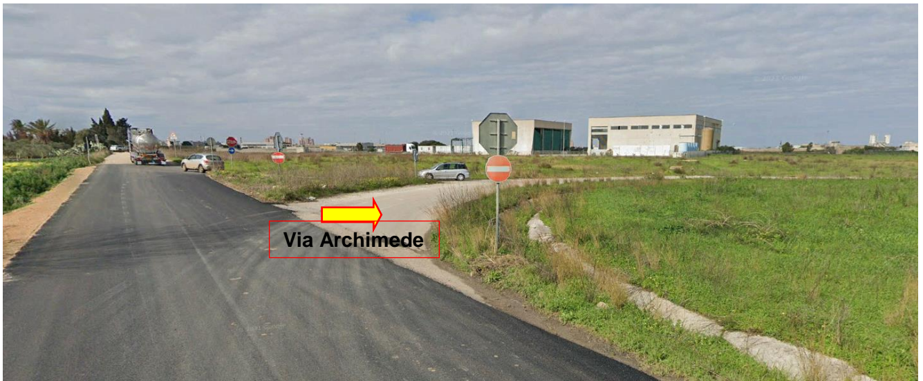
Figura 5-4: SP80 verso via Archimede
