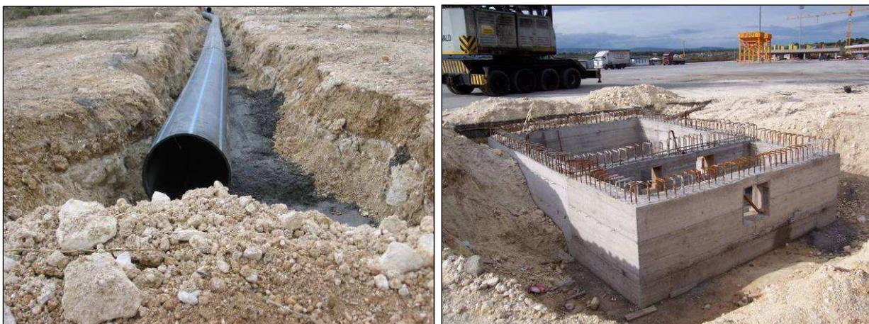
*Figura 17-18: Particolare della tipologia di condotta da impiegare per l'impianto fognario e della vasca di rilancio*
