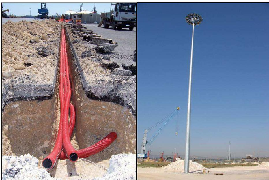
Figura 10 - 11: Particolare posa in opera cavidotti in PVC autoestinguento e della tipologia di torre faro
