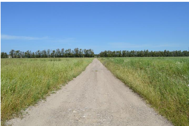
Figura 16 - Strada sterrata per l'accesso al sito. Sulla destra: sito di realizzazione dell'impianto
