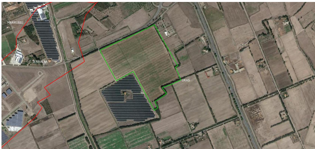
Fig. 1.2 – Area dell'impianto su foto aerea
