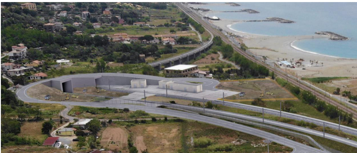
Dettaglio fotosimulazione n. 4: Cantiere Operativo “CO.04” e CO.05”
