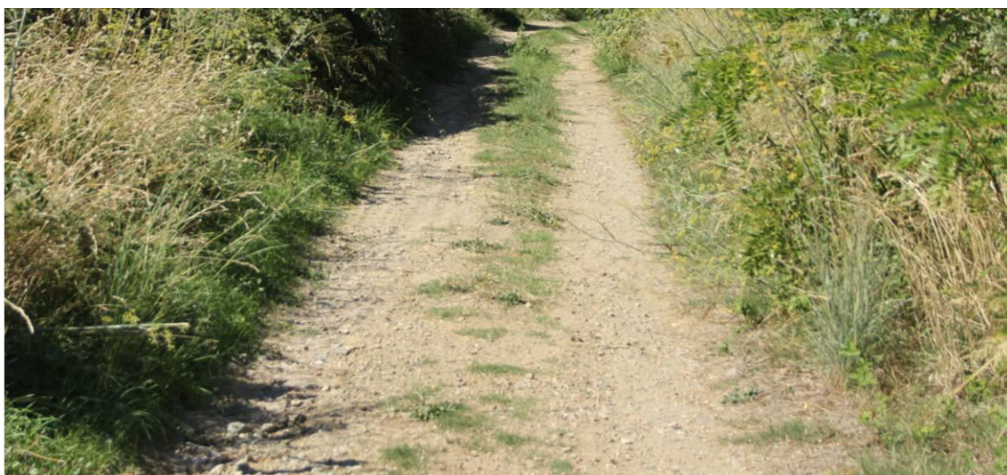
Foto 02. Stato di fatto su quello che era il sedime della vecchia linea storica. Questo tratto è interessato dalla NV07
