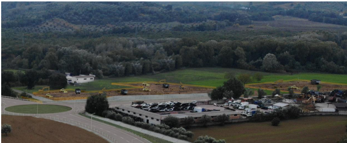
Dettaglio fotosimulazione n. 1: Cantiere Operativo “CO.02” e “CO.03”
