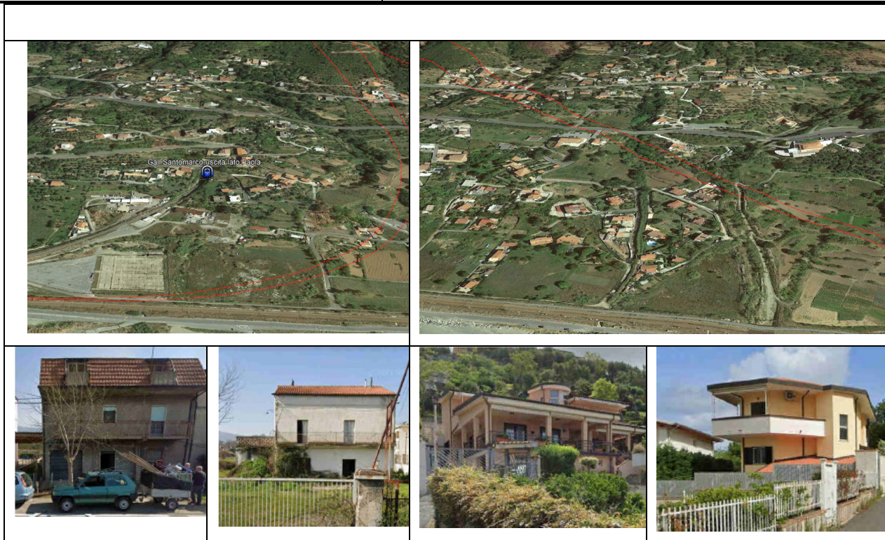
Figura 3-4 Tratto all'aperto Lato Paola, e tipologie costruttive: rilievo fotografico
