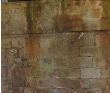
Struttura (spalla) realizzata con pietra grezza calcarea in blocchi di forma rettangolare, murata con tessitura regolare, dimensione media dei blocchi cm 70 x 40, spessore medio dei giunti cm 1.
