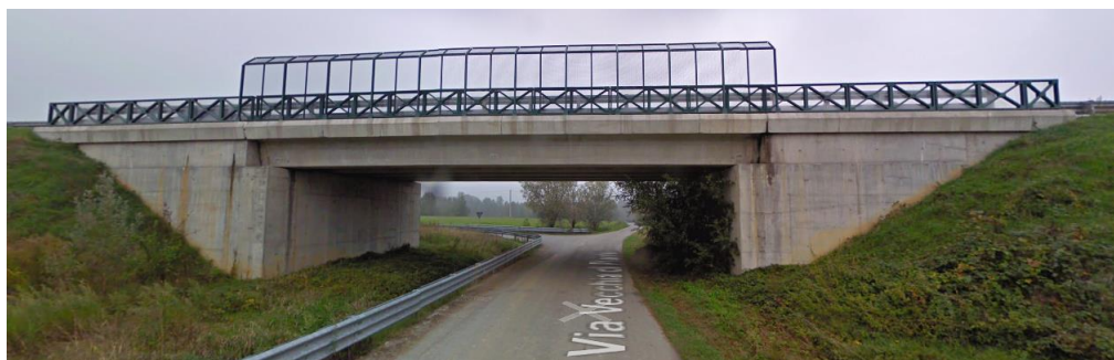
Tangenziale di Mondovì: Tipologia di sottopasso in presenza di viabilità interpodereale
