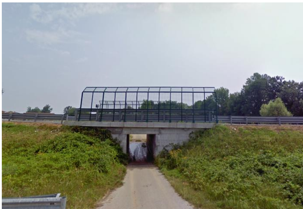
Tangenziale di Mondovì: Tipologia di sottopasso in presenza di viabilità interpodereale
