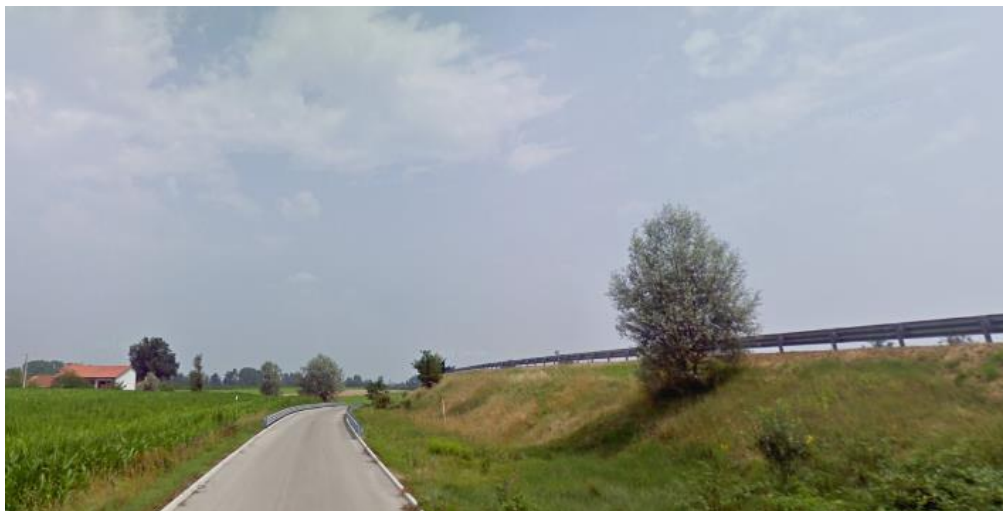
Tangenziale di Mondovì : Tipologia di rinverdimento delle scarpate
