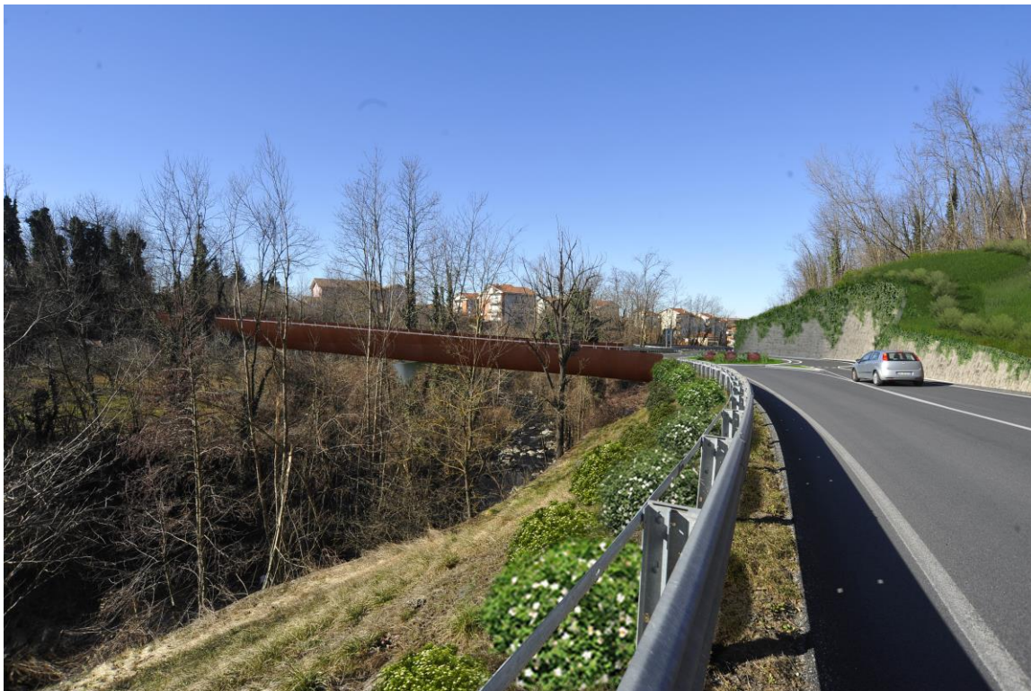
Foto post operam viadotto Torrente Ermena
