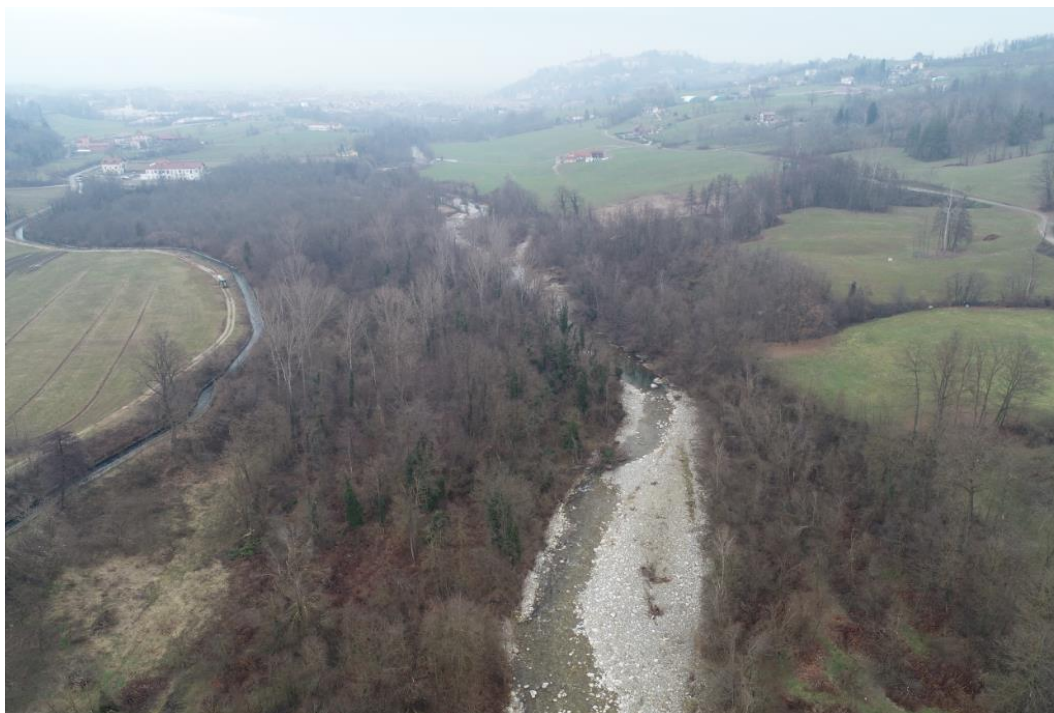
Figura 30: Ante operam - Viadotto Ellero (punto di vista da drone)
